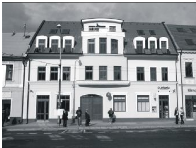
Centrum mesta v týchto dňoch skrášila nová budova, ktorej investorom je súkromný podnikateľský subjekt. Okrem pobočky Unibanky tu bude kaviareň a na poschodí pravdepodobne galéria. Objekt, ktorý projektoval Ing. arch. Vladimír Krušínský, vhodne zapadol do architektúry tejto časti mesta. (mo)
