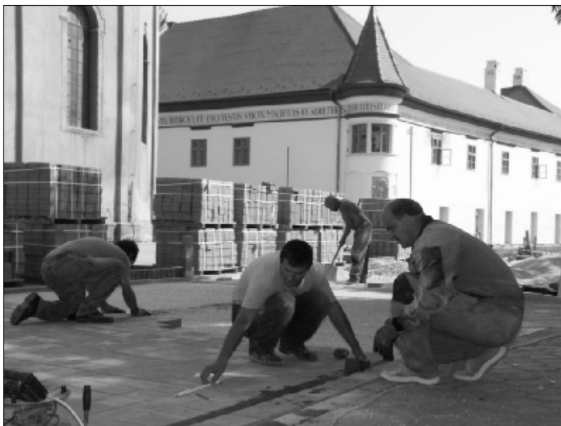
Pracovníci firmy Petmas pri kladení zámkovej dlažby v okolí renovovanej Starej radnice.
