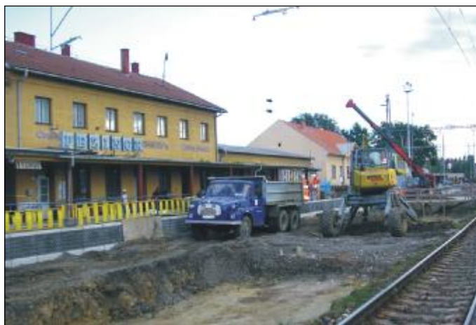
Rekonštrukcia železničnej stanice v Pezinku.
