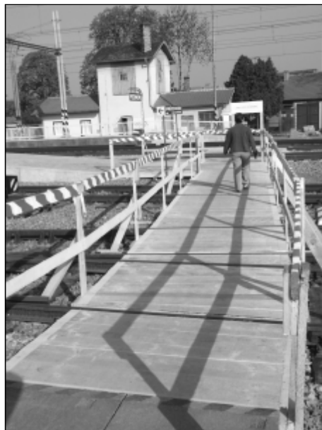
Provizórny priechod cez koľaje.
