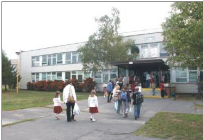
Budová Základnej školy na Kupeckého ulici.
