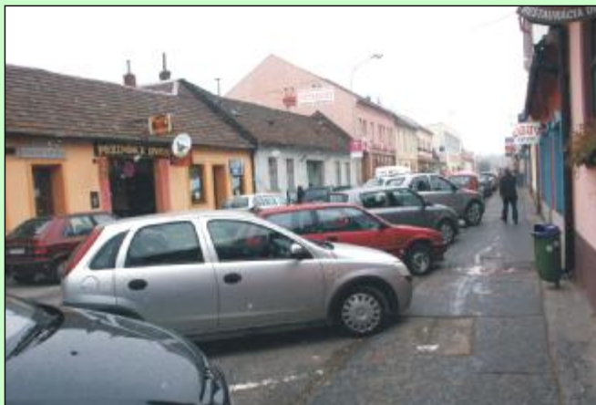
Cestu a chodníky na Kollárovej ulici čaká v budúcom roku rekonštrukcia. Foto (mo)
