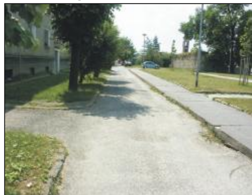
Mladoboleslavská ulica pred rekonštrukciou.
