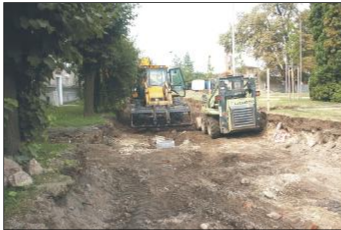
Stavebné stroje na Mladoboleslavskej ulici
