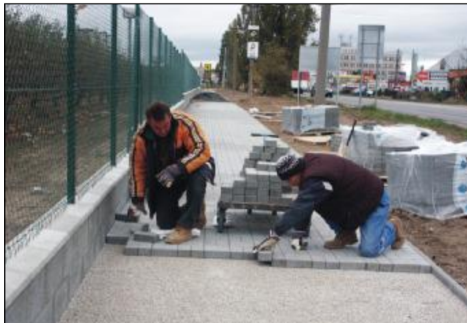
Budovanie chodníka v Grinave.
