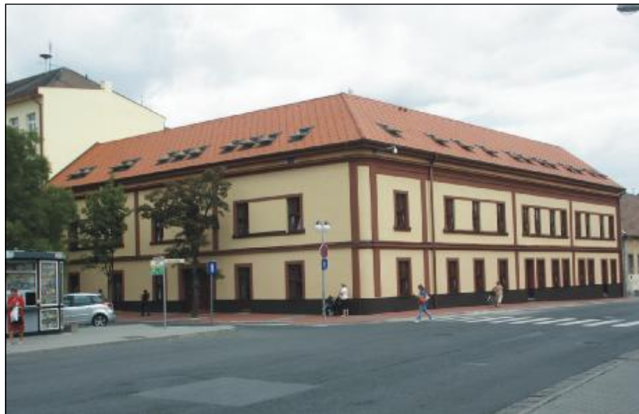
Najväčšia stavba realizovaná v tomto volebnom období – rekonštrukcia mestskej budovy na Radničnom námestí 9
