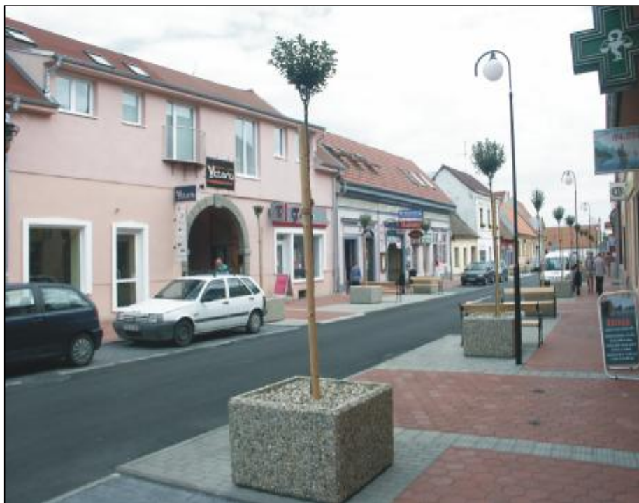
Kollárova ulica po rekonštrukcii
