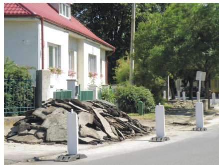
Rekonštrukcia na Trnavskej ul.
