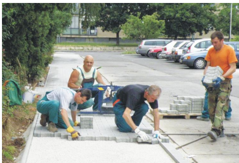
Chodníky zo zámkovej dlažby a asfaltu na ul. Za hradbami.
