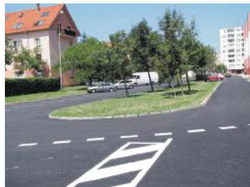
Cesta a parkovisko na Svätoplukovej ul.
