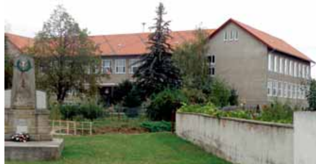
Strecha na ZŠ Orešie sa stihla zrekonštruovať počas letných prázdnin. FOTO (pb)
