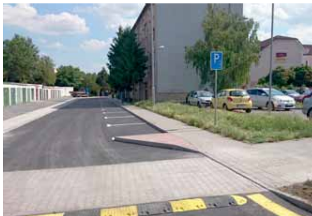
V roku 2015 sa realizovala rekonštrukcia časti Záhradnej ulice. Pribudlo nové parkovisko, chodníky aj asfaltová cesta.
