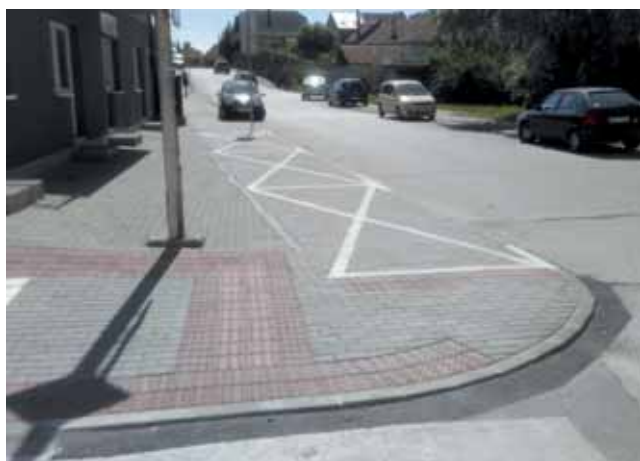
Nové chodníky na sídlisku Sever boli vybudované najmä kvôli bezpečnosti chodcov. Tento vedie konkrétne z Cajle na Novomeského ulicu.
