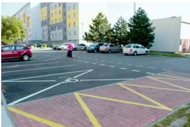
Nové parkoviská a verejné komunikácie v centre sídliska Sever.
