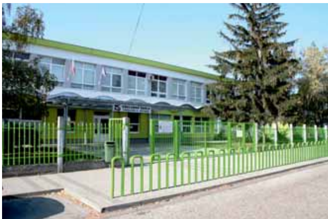
Generálnou rekonštrukciou prešli aj budovy školy na Fándlyho ulici.
