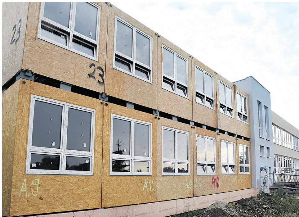
ZŠ Na bielenisku - prístavba modulového pavilónu
