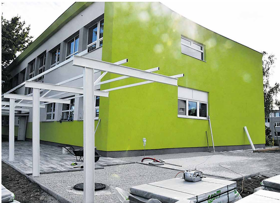
Prípravné práce na umiestnenie kontajnerovej učebne pri ZŠ Fándlyho
