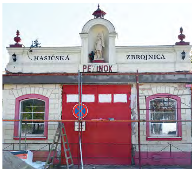
Požiarňa zbrojnica počas rekonštrukcie
