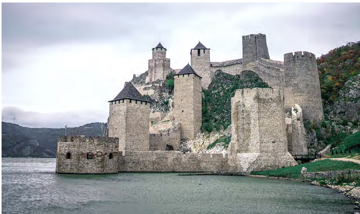
Pevnosť Golubac bola v stredoveku hraničnou pevnosťou na juhu Uhorska nad riekou Dunaj
