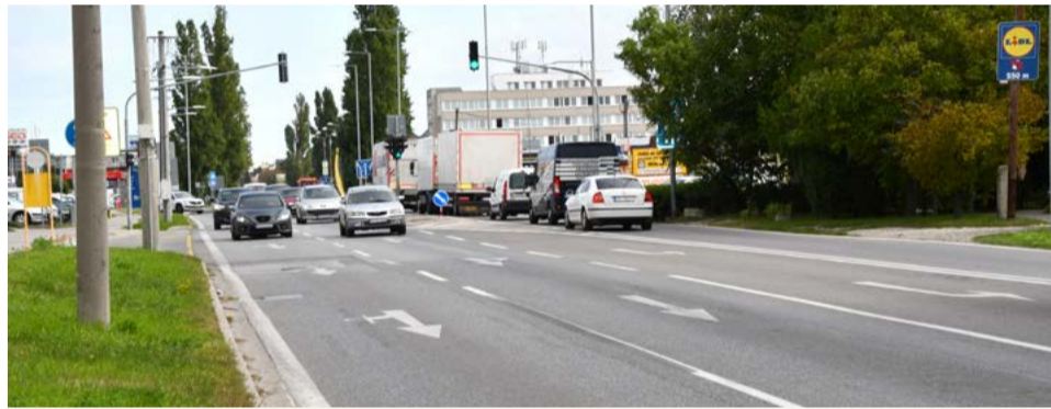
Úsek od Kauflandu po kruhový objazd sa začne rekonštruovať začiatkom júna
