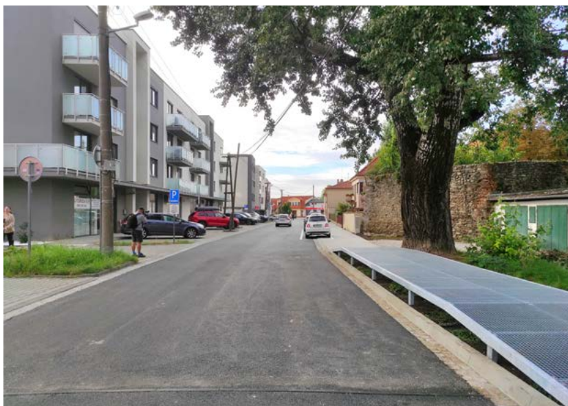
Novinkou na Šancovej ulici je lávka, ktorá chráni prírodnú pamätihodnosť
