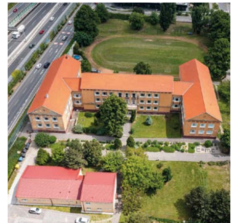
Gymnázium Alberta Einsteina pred rekonštrukciou
