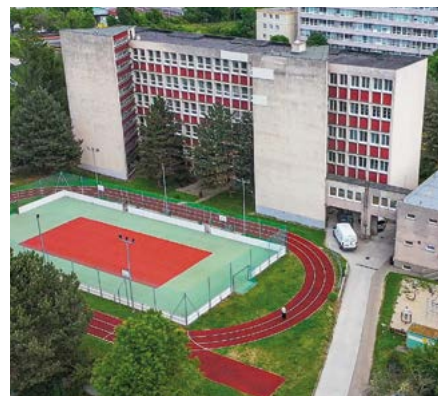
Obchodná akadémia, Račianska 107 pred rekonštrukciou
