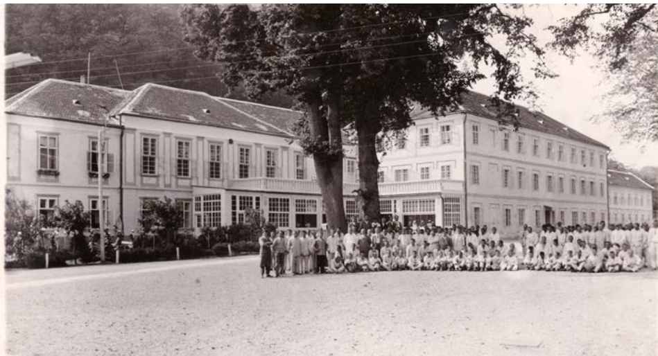
Mužské oddelenie Afilovaného ústavu, budova niekdajších železných kúpeľov
