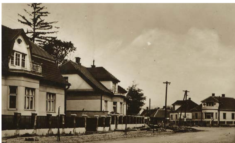
Vilová zástavba v dolnej časti Rázusovej ulice
