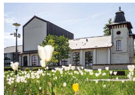
Divadlo Aréna po komplexnej obnove a modernizácii
