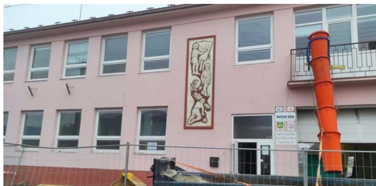
Modernizácia budovy sa začala v polovici januára
