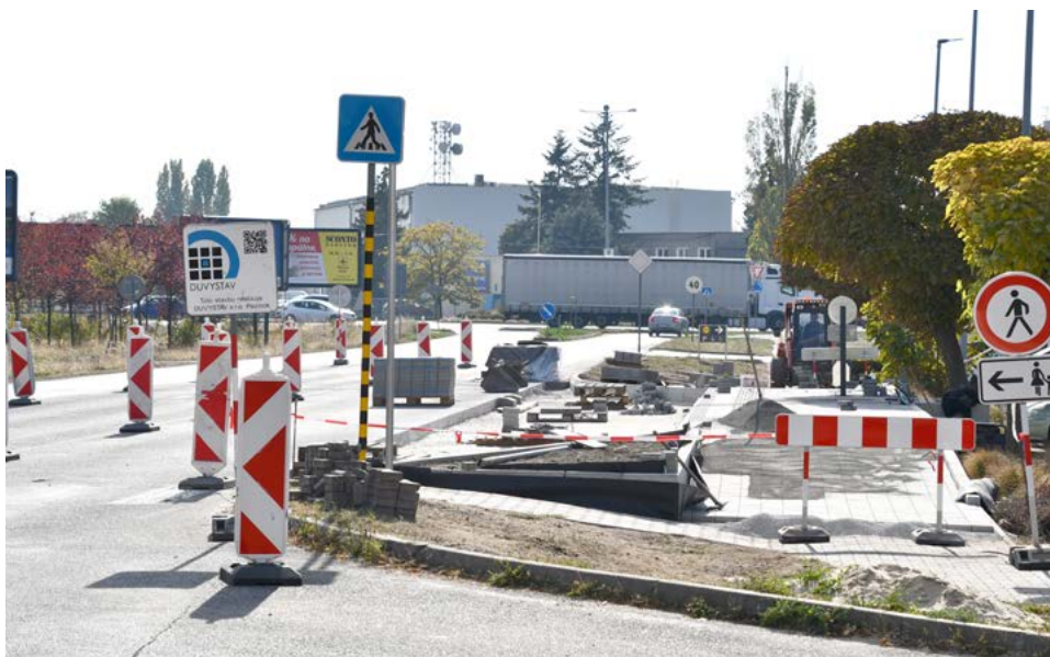
Zastávka na Okružnej ulici vo výstavbe
