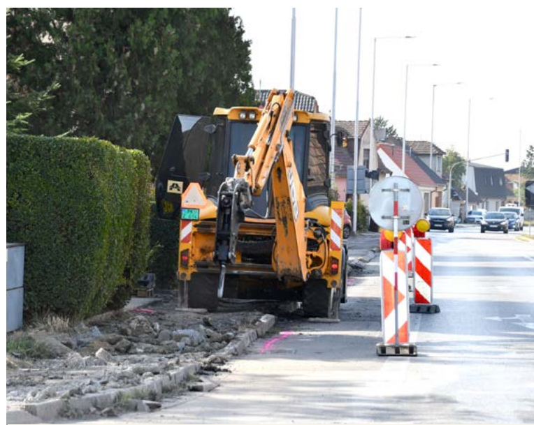
Nový povrch chodníka pribudne v úseku medzi domami č. 25 až 53
