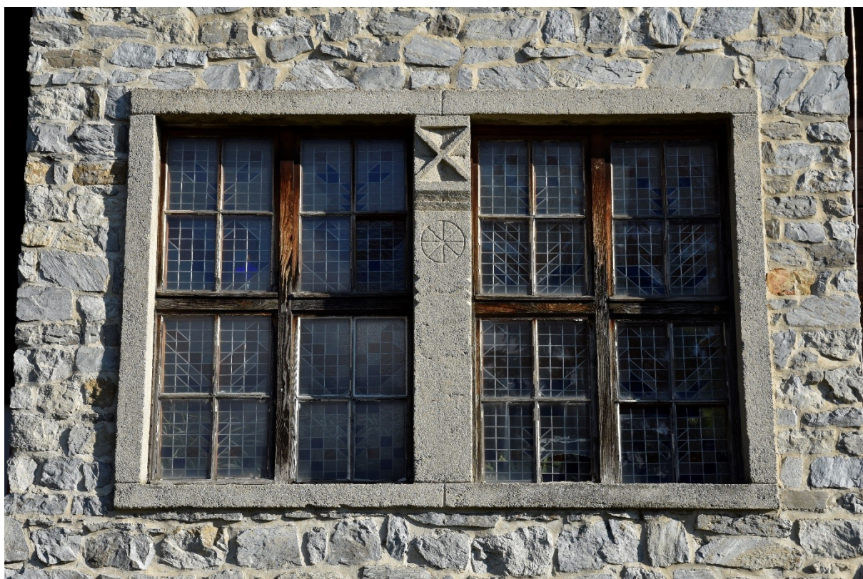
Detail združeného okna s vitrážami, osadeného v kamennom ostení západného rizalitu
