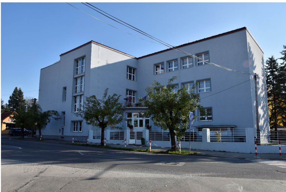
Aktuálny pohľad na pôvodnú časť meštianskej školy
