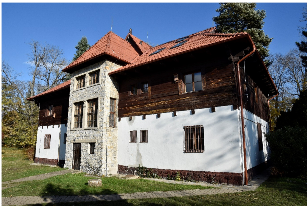
Západný pohľad na fasádu budovy s rizalitom vyhotoveným z lomového kameňa
