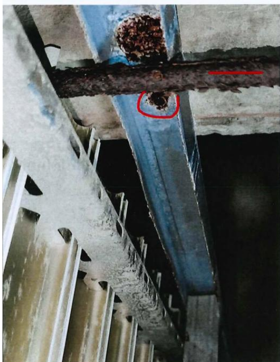
Obr. 1 Skorodované kotvenie podhl'adu
