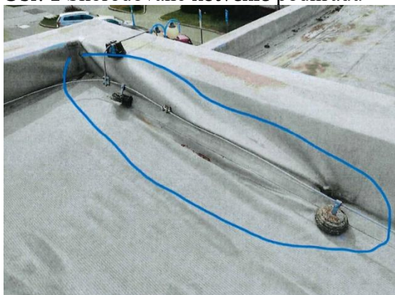
Obr. 1 Skorodované kotvenie podhl'adu
