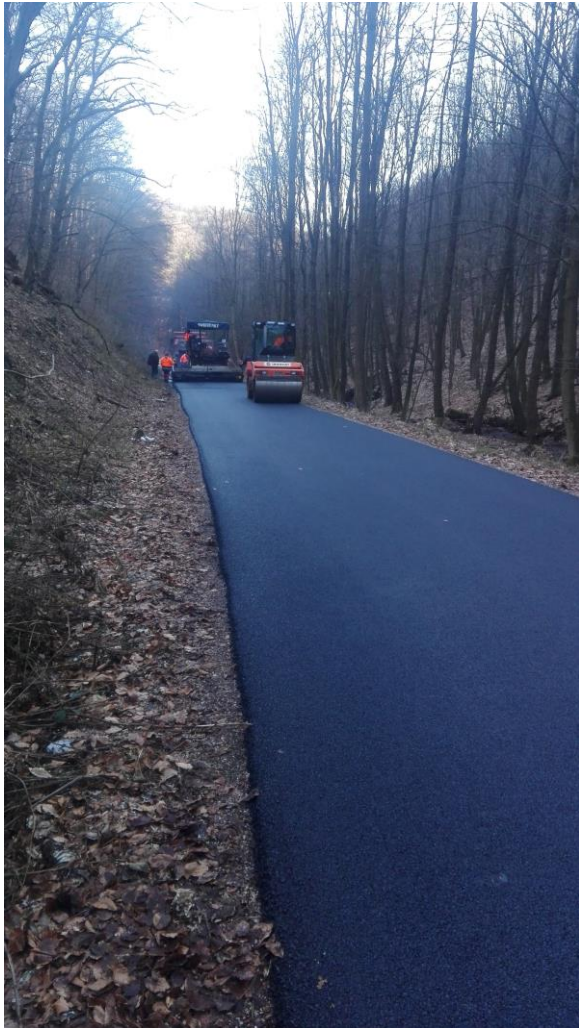
Obr 2 a 3. Asfaltárske práce na ceste na Slnčné údolie
