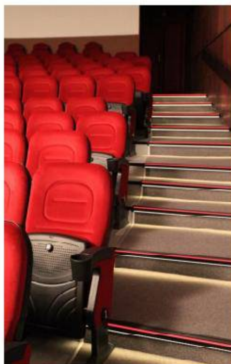
Ukážka LED osvetlenia schodiska v kine v Topoľčanoch
