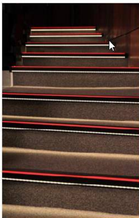
Ukážka LED osvetlenia schodiska v kine v Topoľčanoch
