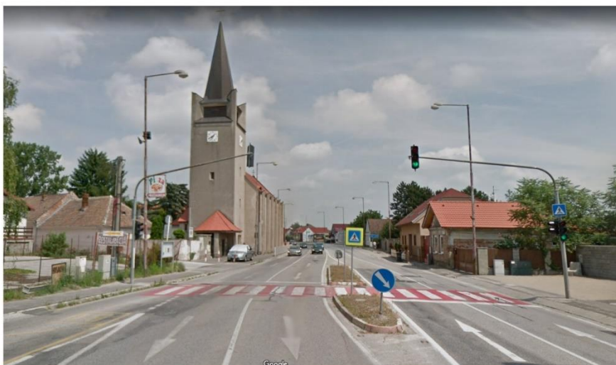
Cestná svetelná signalizácia na prechode pre chodcov na ceste II/502 v km 16,150
