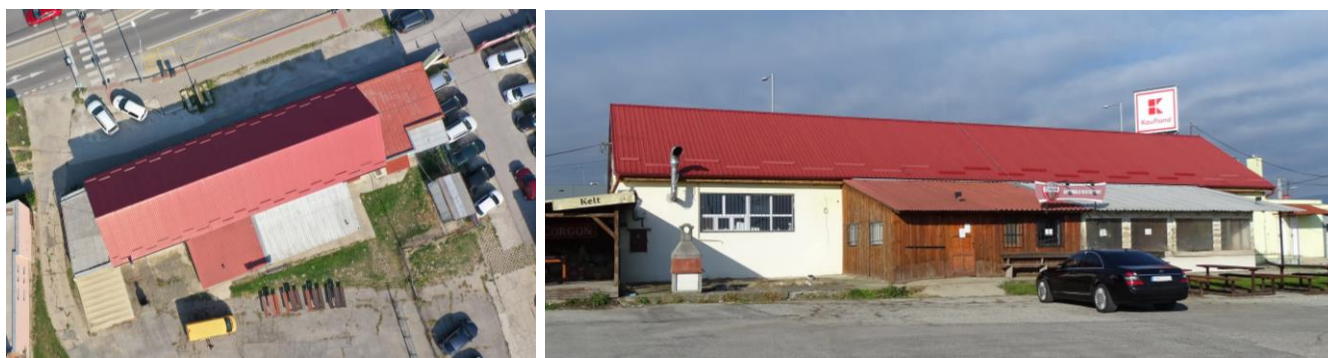
Obr. č. 6 – Strecha objektu
