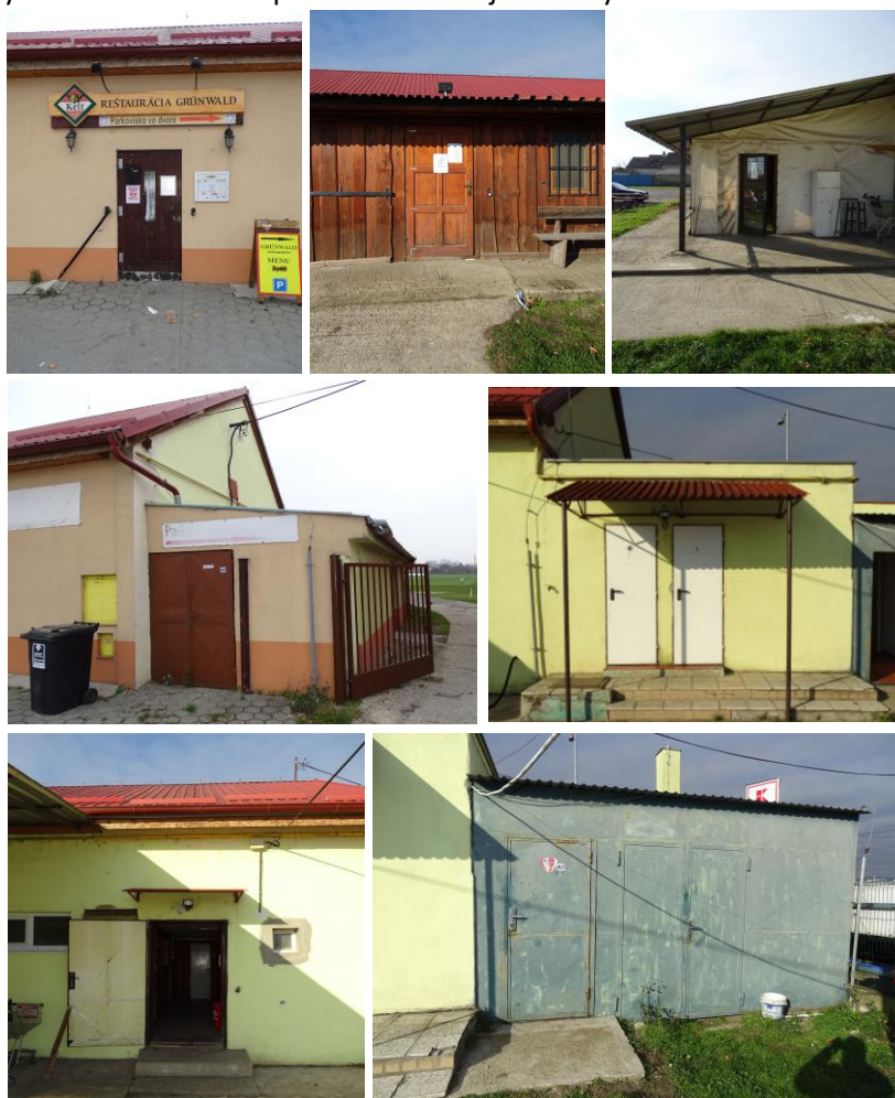
Obr. č. 2 Vstup do budovy - reštaurácie, zadný východ z reštaurácie na dvor, zadný východ z prestrešenej terasy, vstupy do skladov, vstupy do WC, vstup do časti užíwanej futbalovým klubom, vstup do rozhodcovskej miestnosti a vstup do kotolne.
