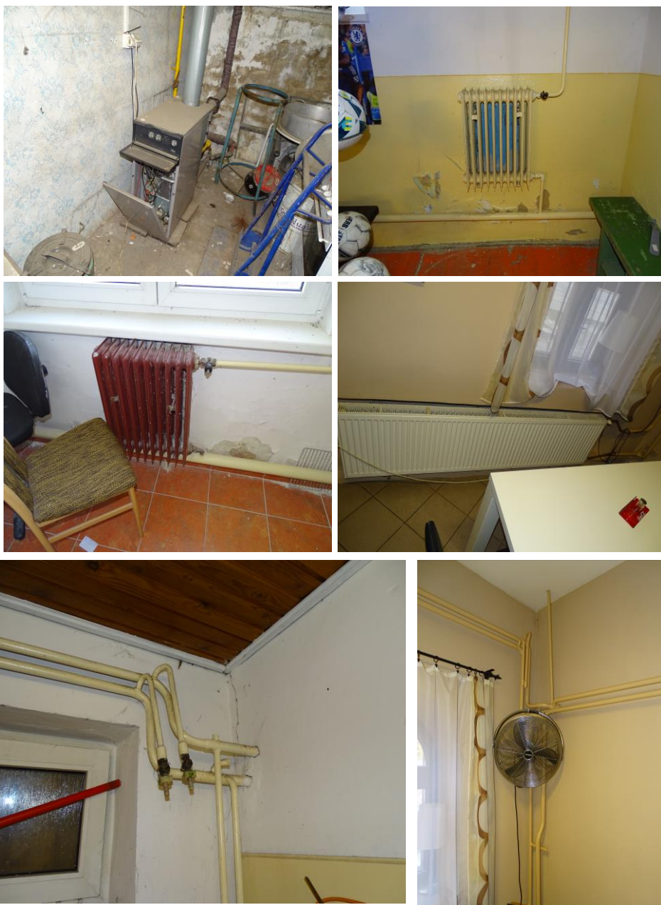
Obr. č. 15 Vykurovanie – plynový kotol, pôvodný liatinový radiátor, nový oceľový radiátor, oceľové vykurovacie rozvody.
