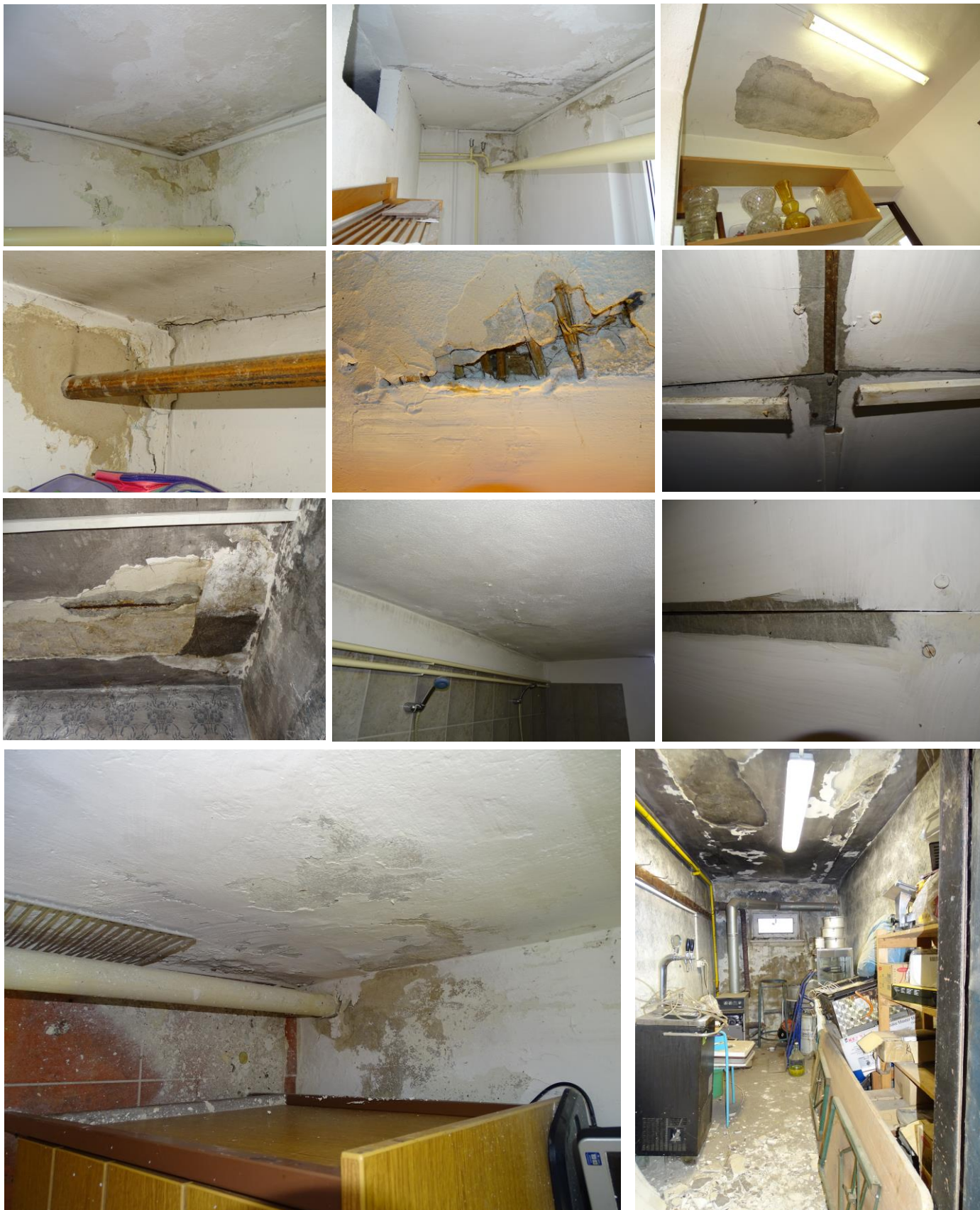
Obr. č. 5 – Úpravy stien interiéru – defekty spôsobené zatekaním, premrzaním so vznikom následných plesní a po zásahu pri požiari
