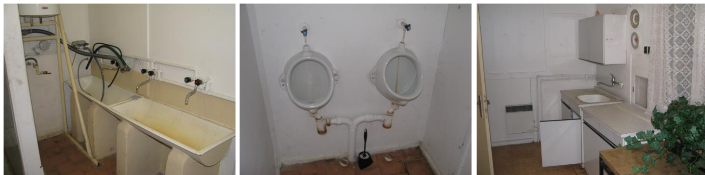
Obr. č. 8 Sociálne zariadenie, kuchynka
