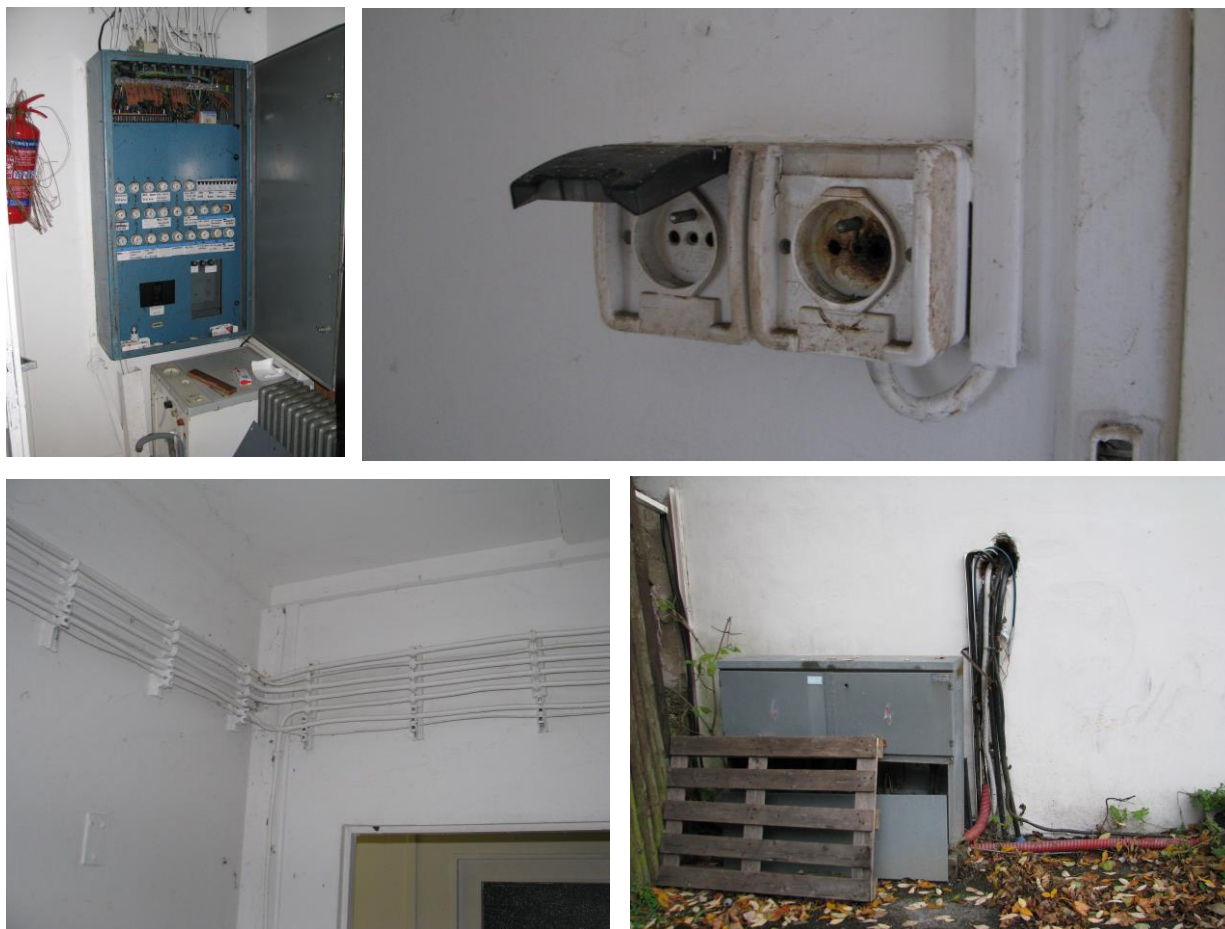
Obr. č. 10 – pôvodné rozvody, osvetlenie a vypínače, bleskozvod, rozvádzače
