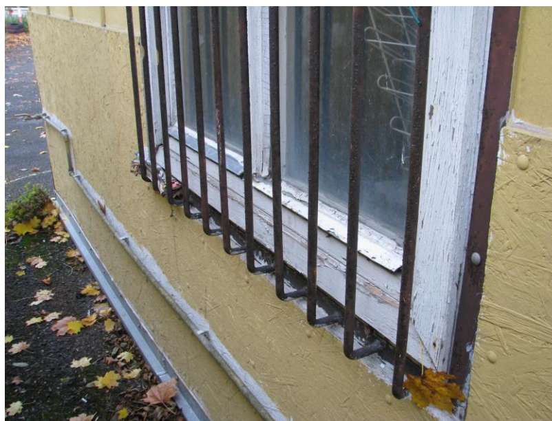
Obr. č. 4 - Otvorové konštrukcie – dvere a okná
