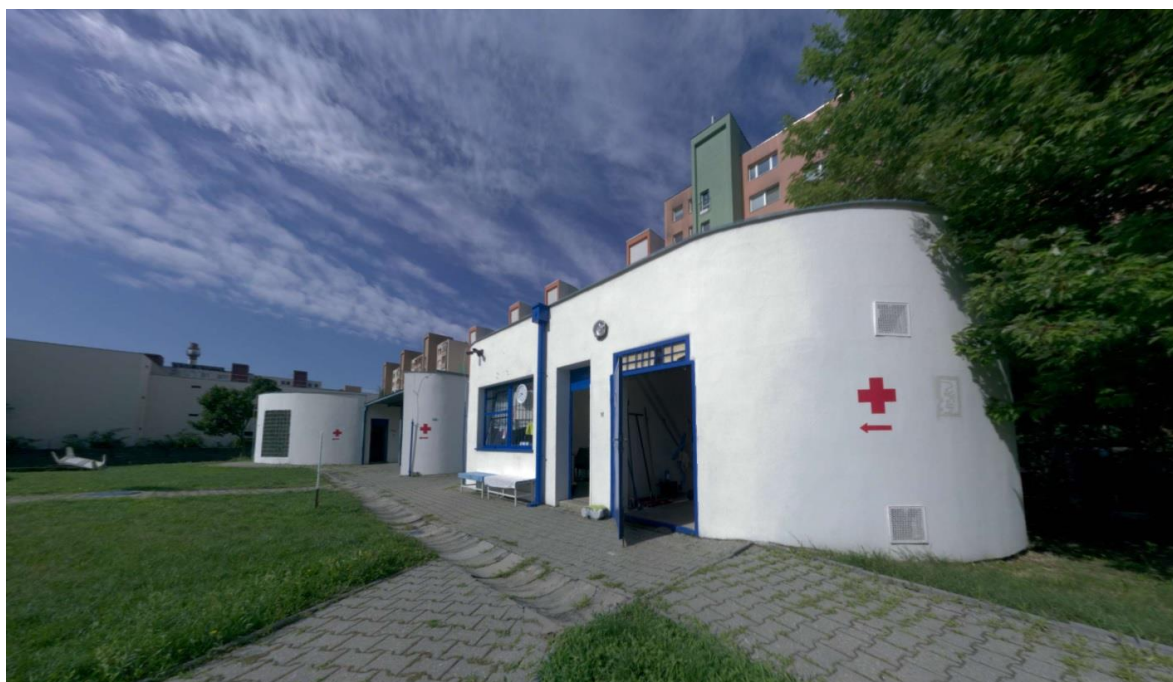
Obr. č. 4 – Objekt SO 02 – Technológia
