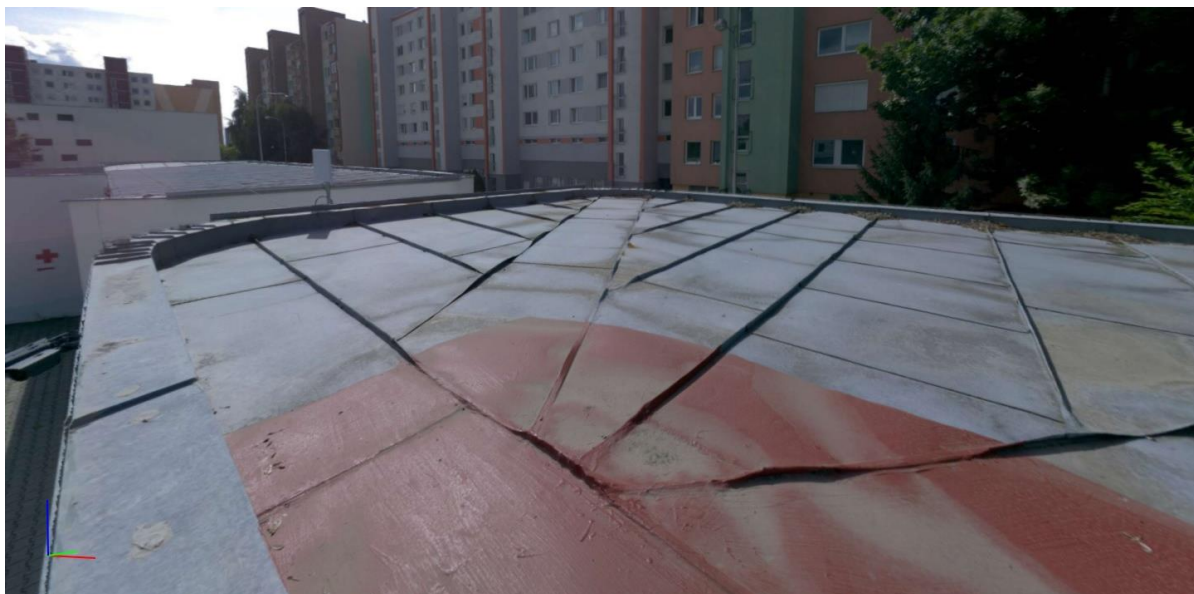
Obr. č. 14 – Plechová strecha objektu SO 02 - Technológia
