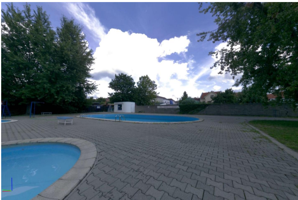
Obr. č.16 – Spevnené plochy v areáli letného kúpaliska
