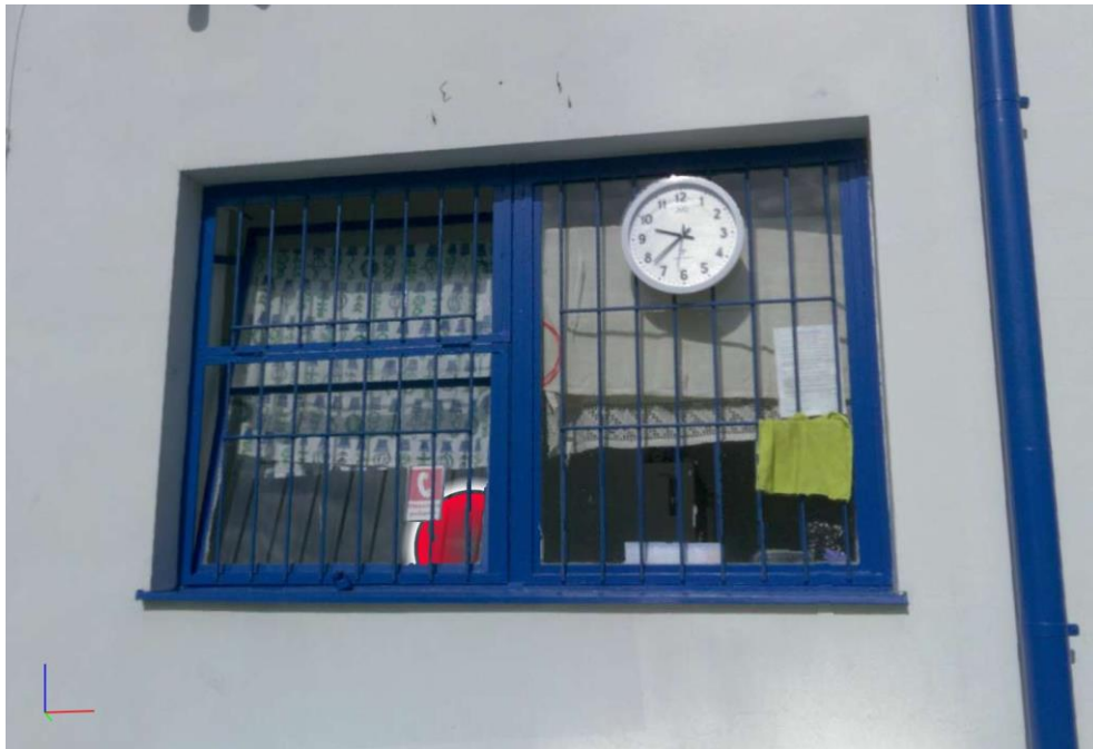
Obr. č. 7 - Pôvodné drevené okno s mrežou
