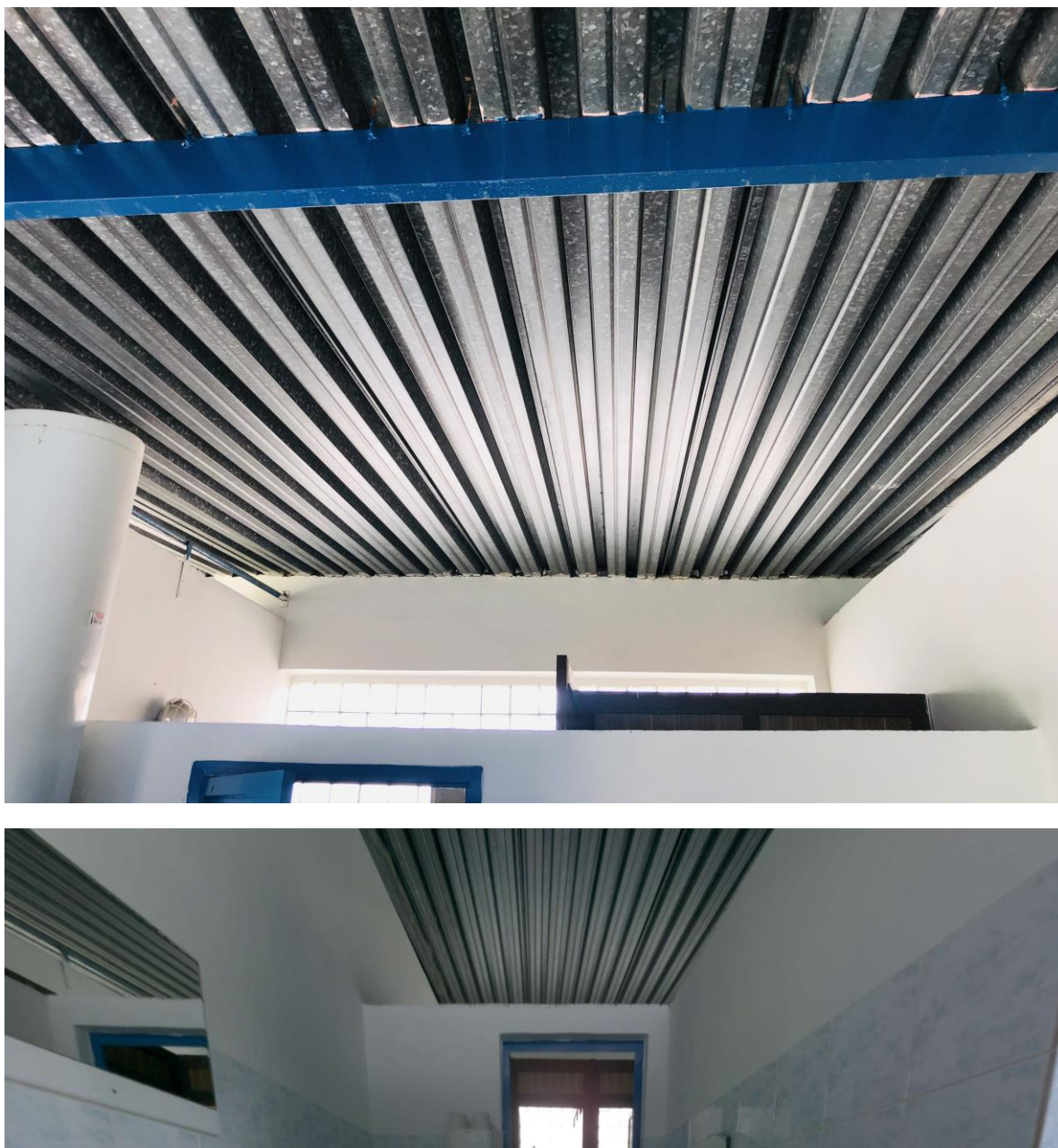
Obr. č. 11 – Trapézový plechový strop v šatniach a sociálnych zariadeniach
