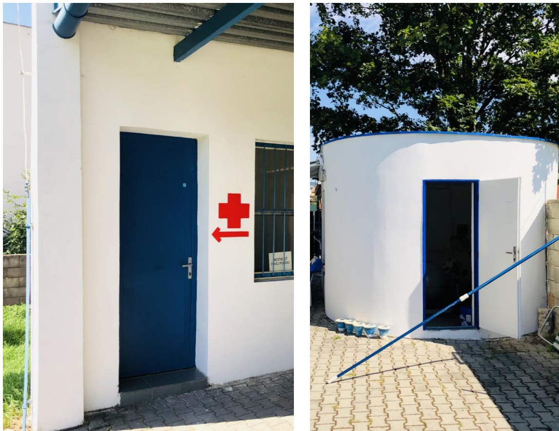
Obr. č. 2 – Bariérový vstup do objektov letného kúpaliska
