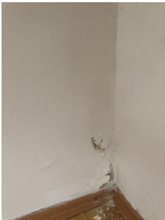
Obr. č. 16 a – Poškodená a zavlhnutá stena v zasadacej miestnosti a sociálnych zariadeniach
