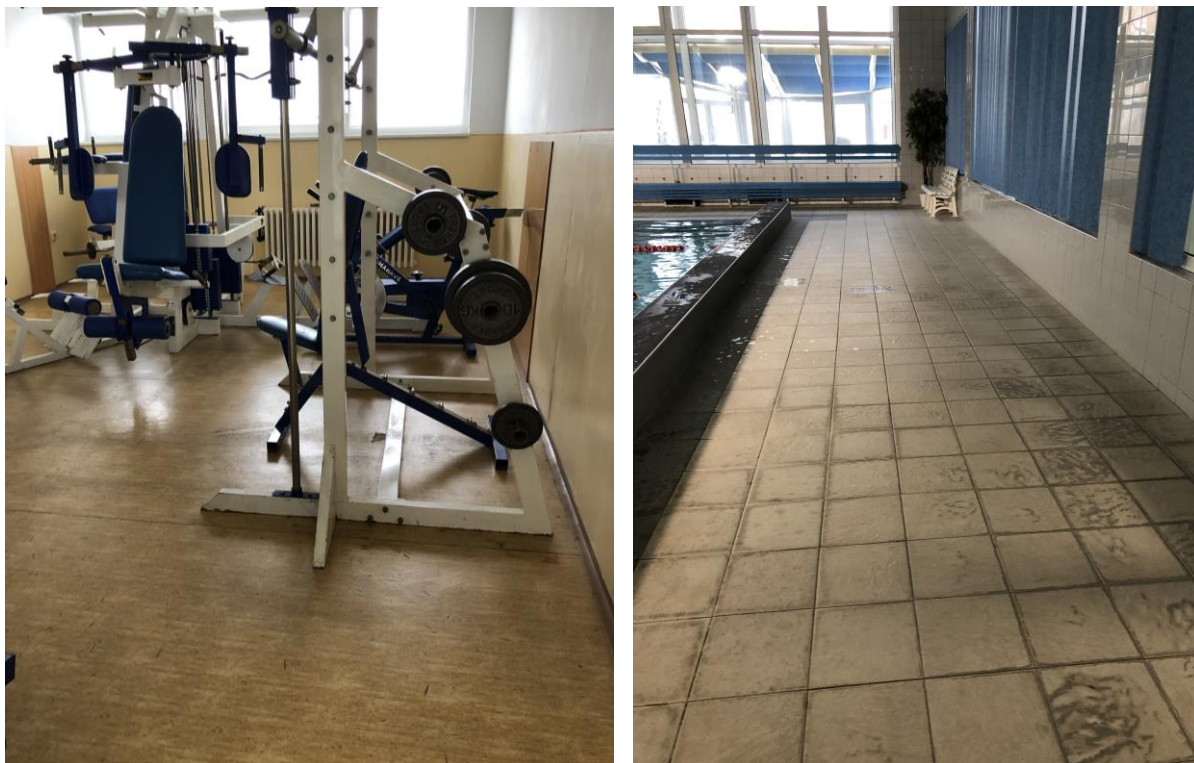
Obr. č. 12 – Pôvodná podlaha vo fitness a pri plaveckom bazéne
