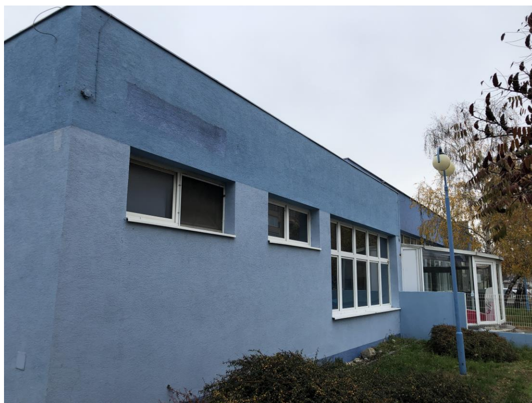
Obr. č. 3a – Pohľady na fasádu objektu
