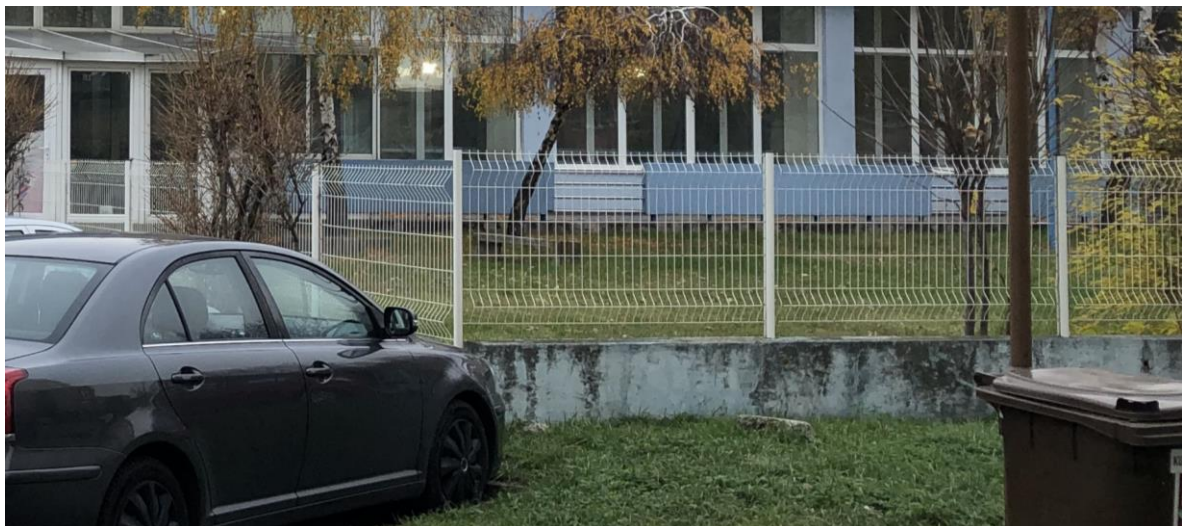
Obr. č. 18 – Oplotenie areálu plavárne
