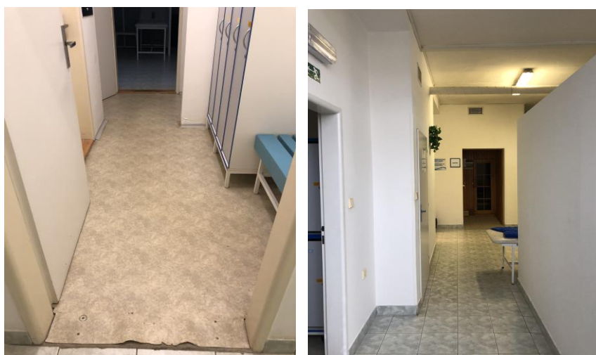
Obr. č. 11 – Podlaha na chodbách
