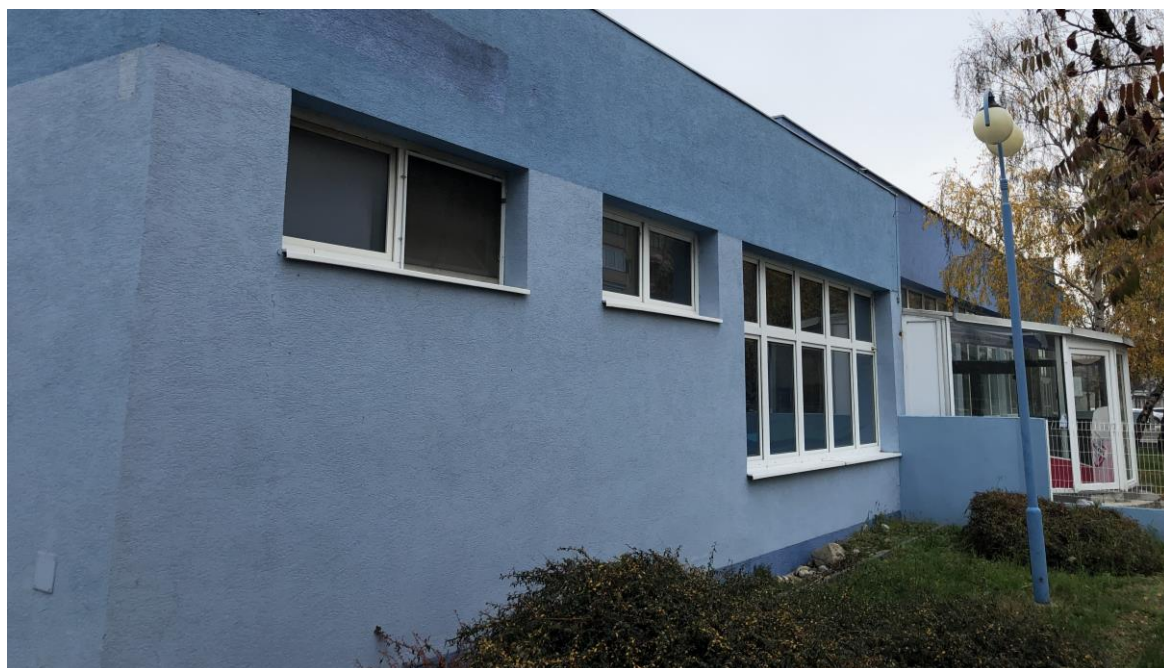
Obr. č. 7 - Vymenené otvorové konštrukcie – plastové okna s izolačným dvojsklom
