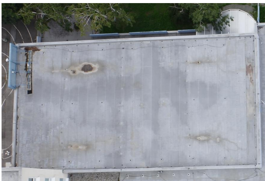
Obr. č.29 – Bleskozvod
