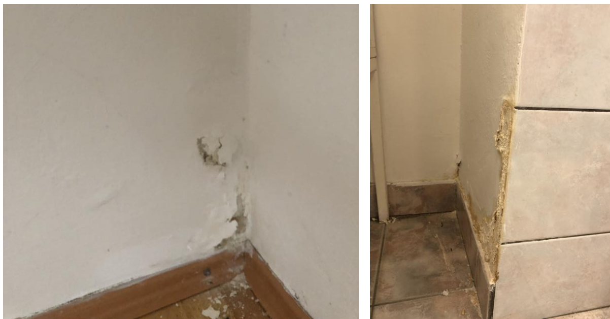
Obr. č. 6 – Zavlhnuté miesta v šatni a zasadacej miestnosti .
