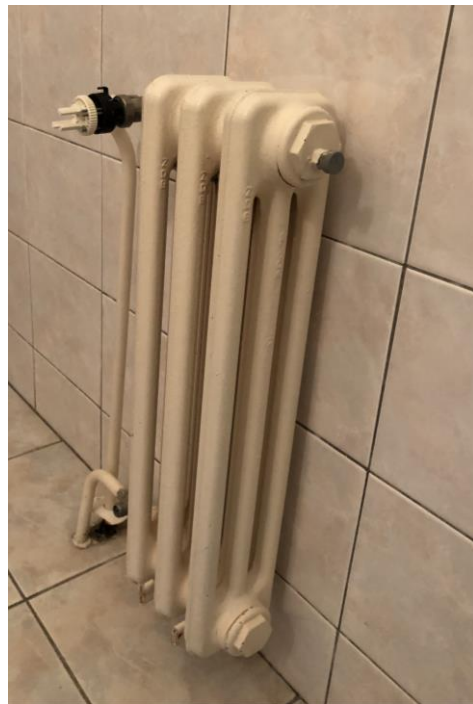
Obr. č.24 – Radiátor bez termostatickej hlavice, resp. s poškodenými hlavicami
