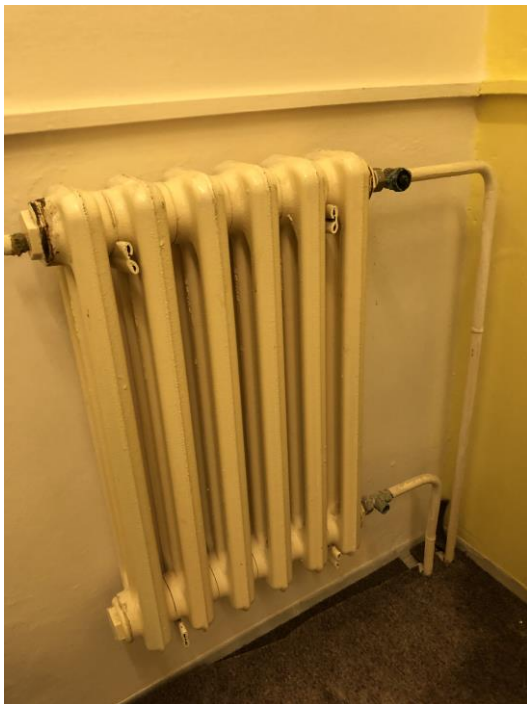
Obr. č.24 – Radiátor bez termostatickej hlavice, resp. s poškodenými hlavicami
