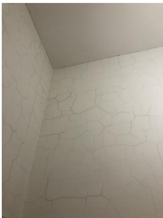
Obr. č. 4 b – Trhliny na strope a na stene objektu
