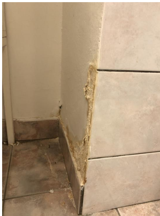
Obr. č. 16 a – Poškodená a zavlhnutá stena v zasadacej miestnosti a sociálnych zariadeniach
