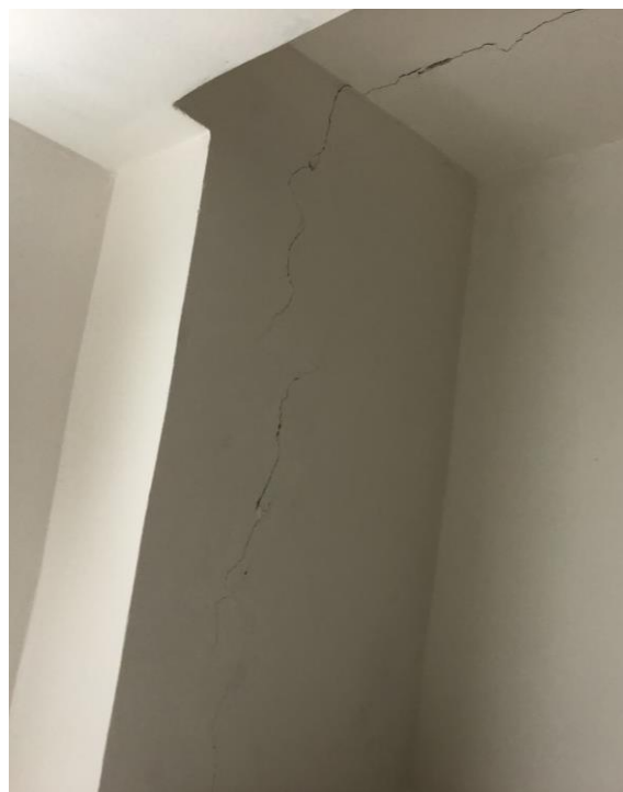
Obr. č. 4 b – Trhliny na strope a na stene objektu
