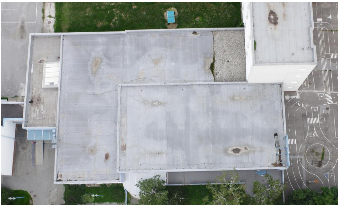
Obr. č. 13 – Strecha krytej plavárne
