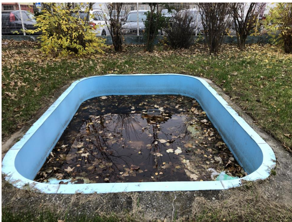
Obr. č.19 – Vonkajší detský bazén
