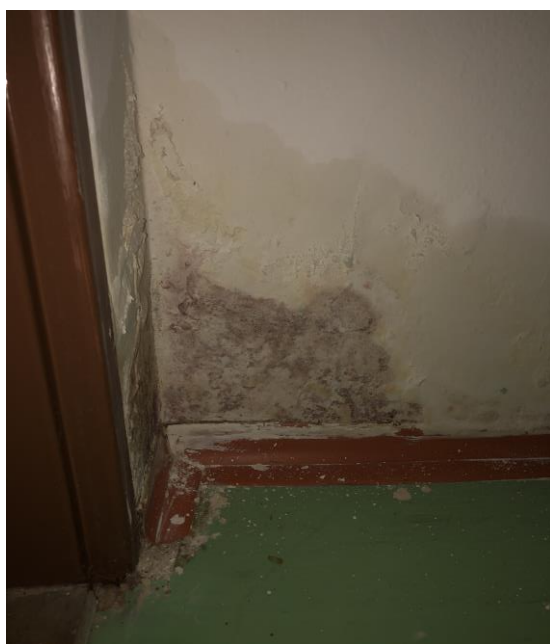
Obr. č. 5 – Zavlhnuté steny v technických priestoroch na prízemí
