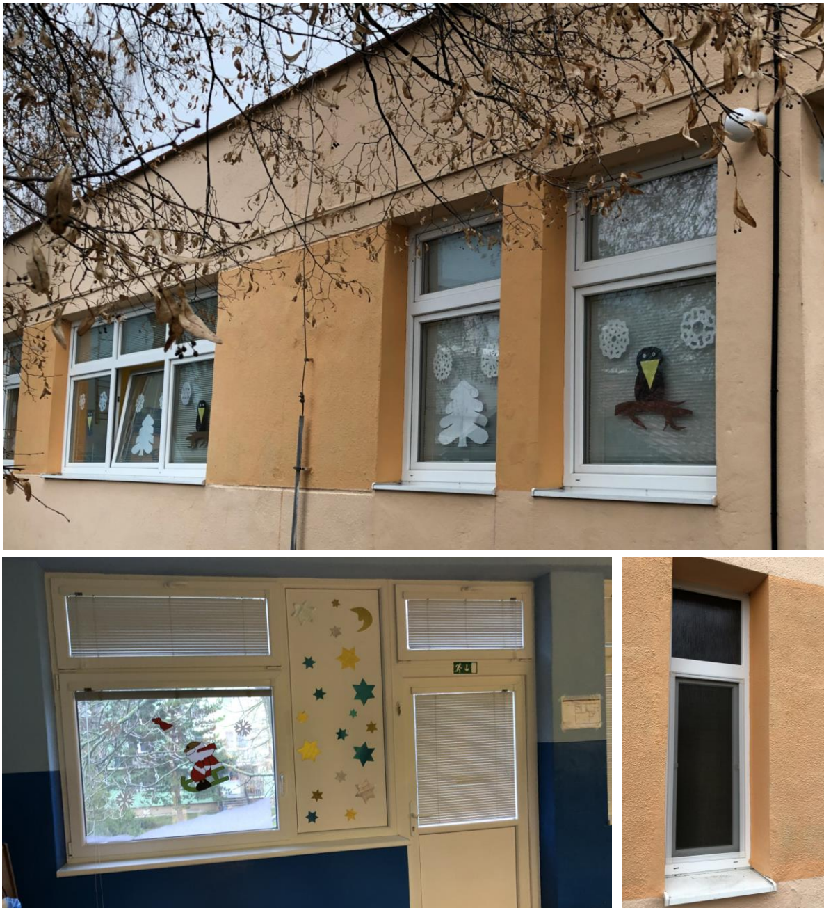
Obr. č. 6 - Vymenené otvorové konštrukcie – plastové okna s izolačným dvojsklom
