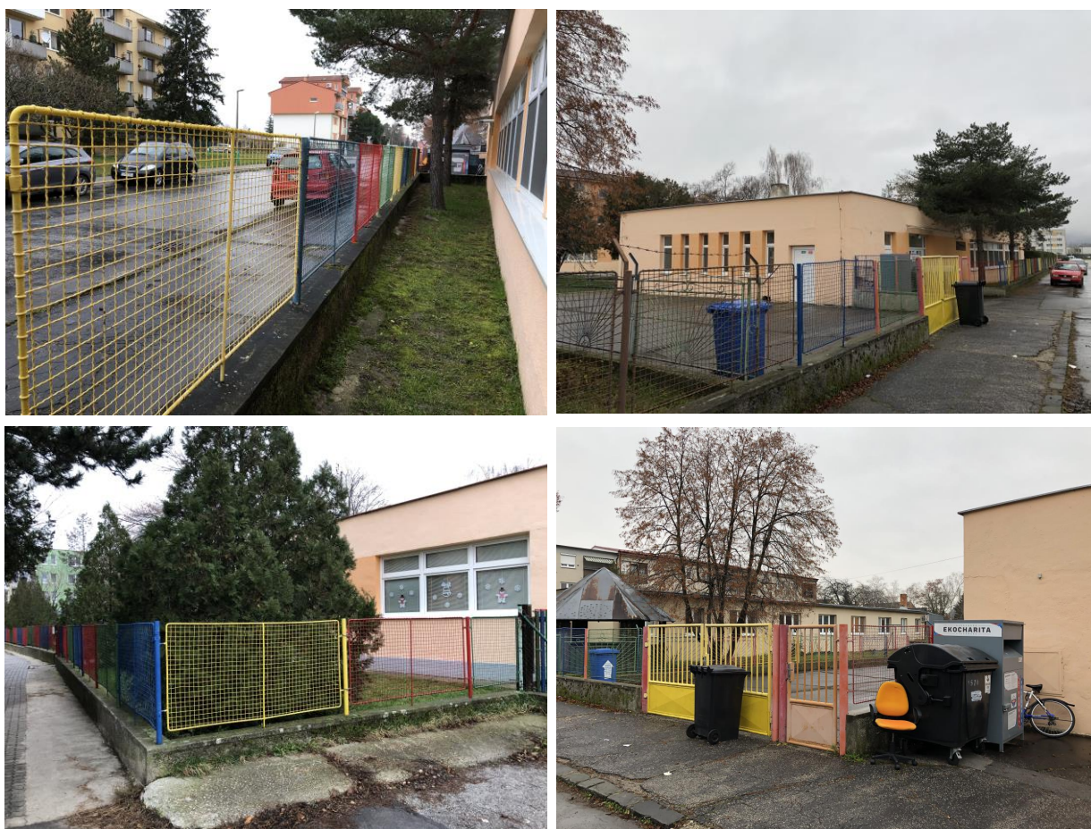
Obr. č. 19 – Oplotenie areálu materskej školy
