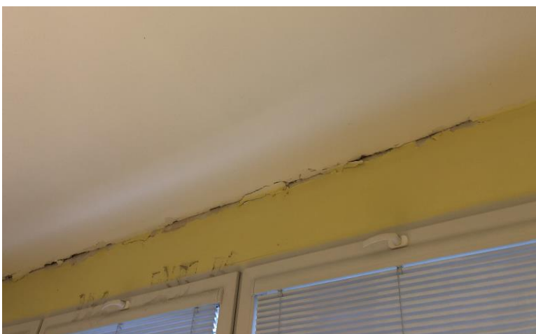
Obr. č. 4 – Trhliny a opadnutá časť omietky na strope
