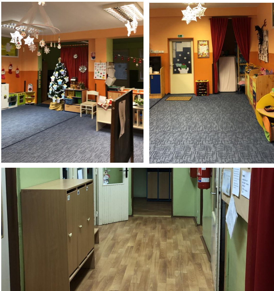
Obr. č. 12 – Podlahy v triedach a na chodbách
