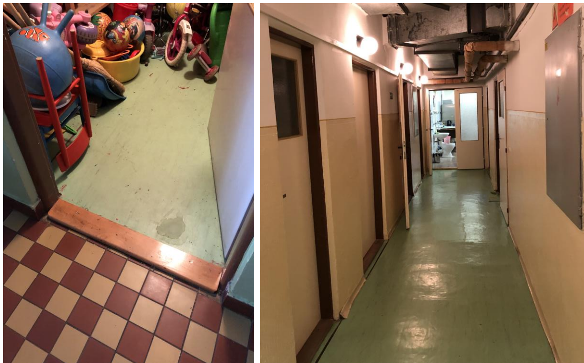
Obr. č. 14 – Pôvodná podlaha v sklade a na chodbe
