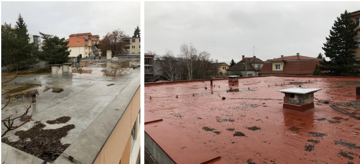
Obr. č. 13 – Plochá strecha objektu
