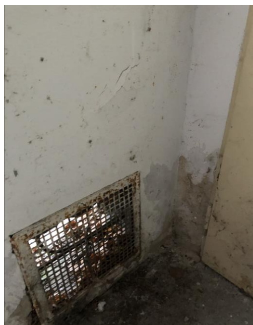
Obr. č. 5 – Zavlhnuté steny v technických priestoroch na prízemí
