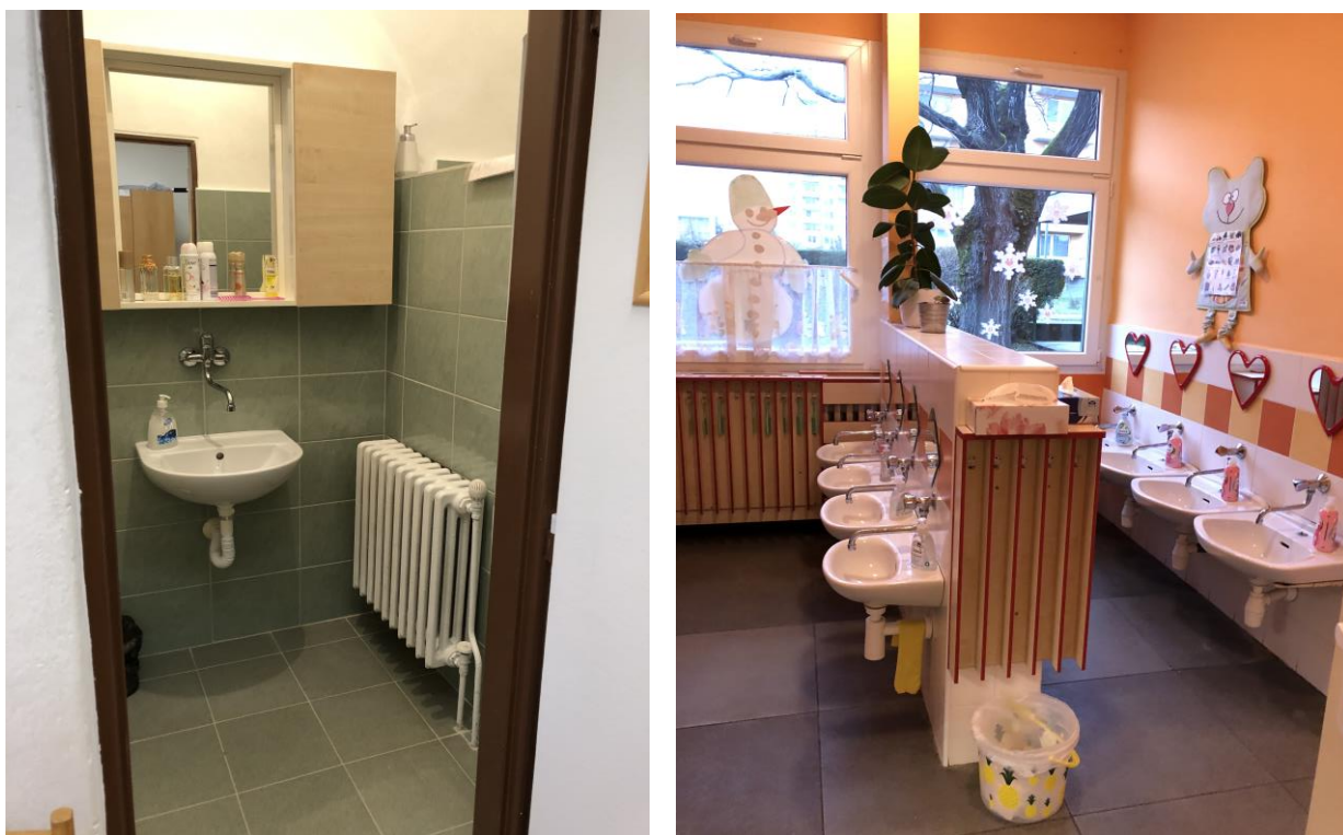
Obr. č. 11 – Úpravy stien interiéru s obkladom
