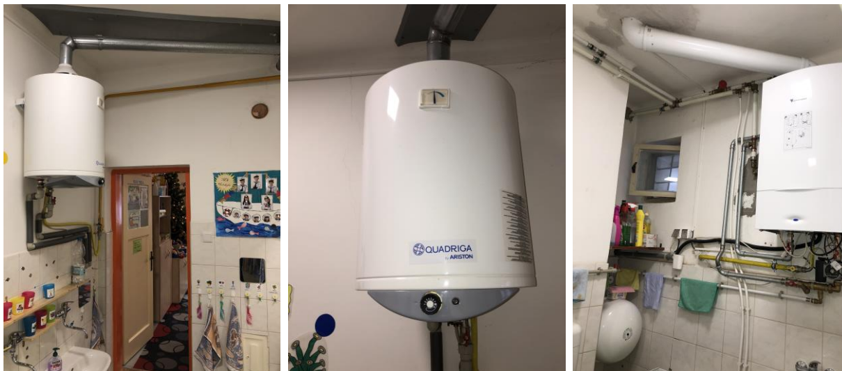
Obr. č. 16 – Plynový kotol, plynový ohrievač TUV - umyvárka
