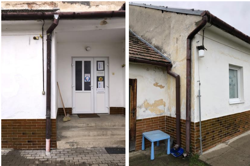
Obr. č. 14 – Dažďové zvody odvedené voľne na terén/do kanalizácie
