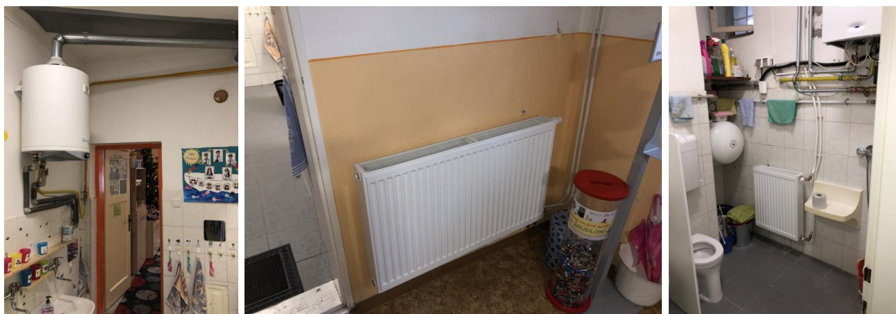
Obr. č. 6 – Úpravy stien interiéru
