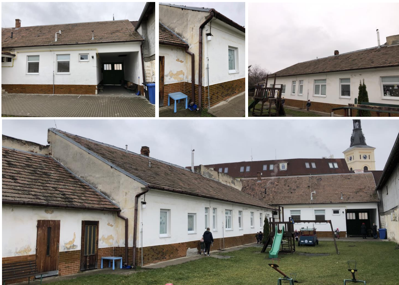
Obr. č. 3 – Pohľady na fasádu objektu
