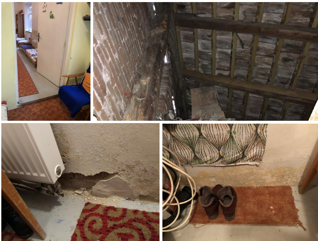
Obr. č. 7 – Podlahy v objekte, krov, strecha
