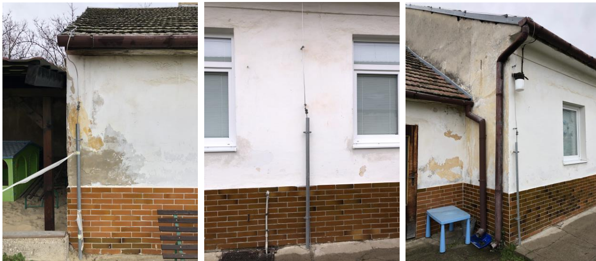
Obr. č. 20 – Bleskozvod
