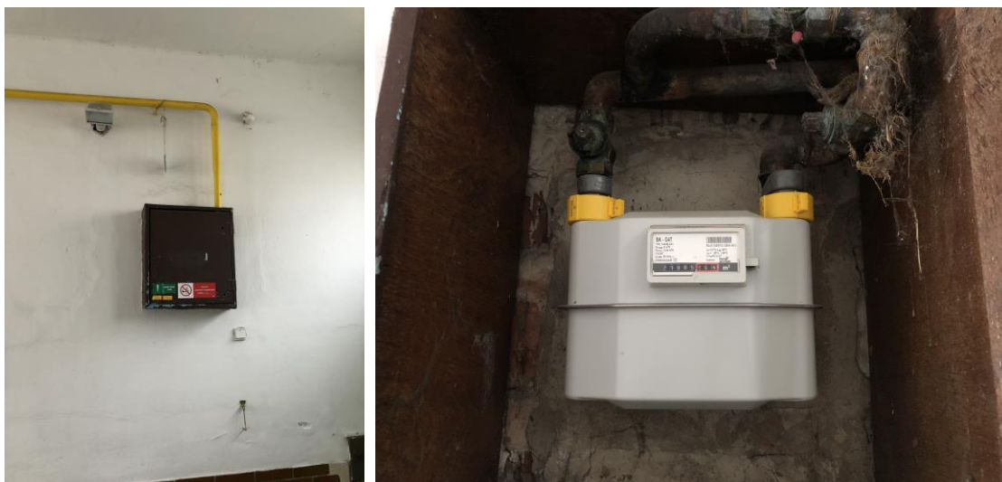
Obr. č. 15 – HUP a trasovanie rozvodu plynu
