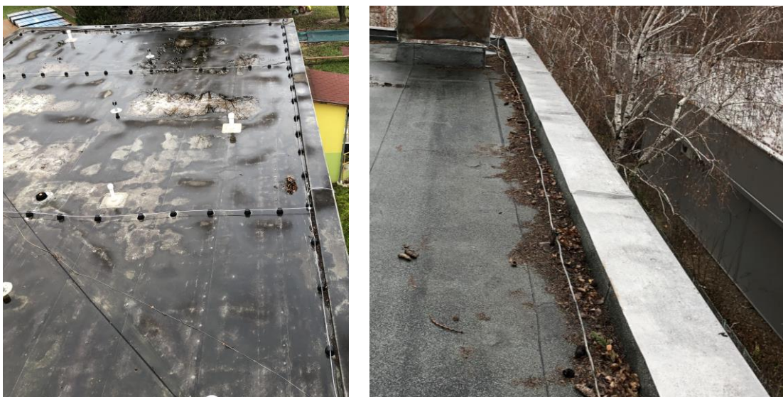
Obr. č.24 – Bleskozvod
