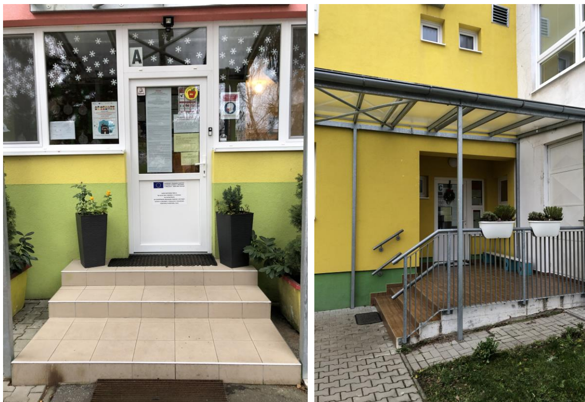
Obr. č. 2 – Bezbariérový vstup do objektu školy
