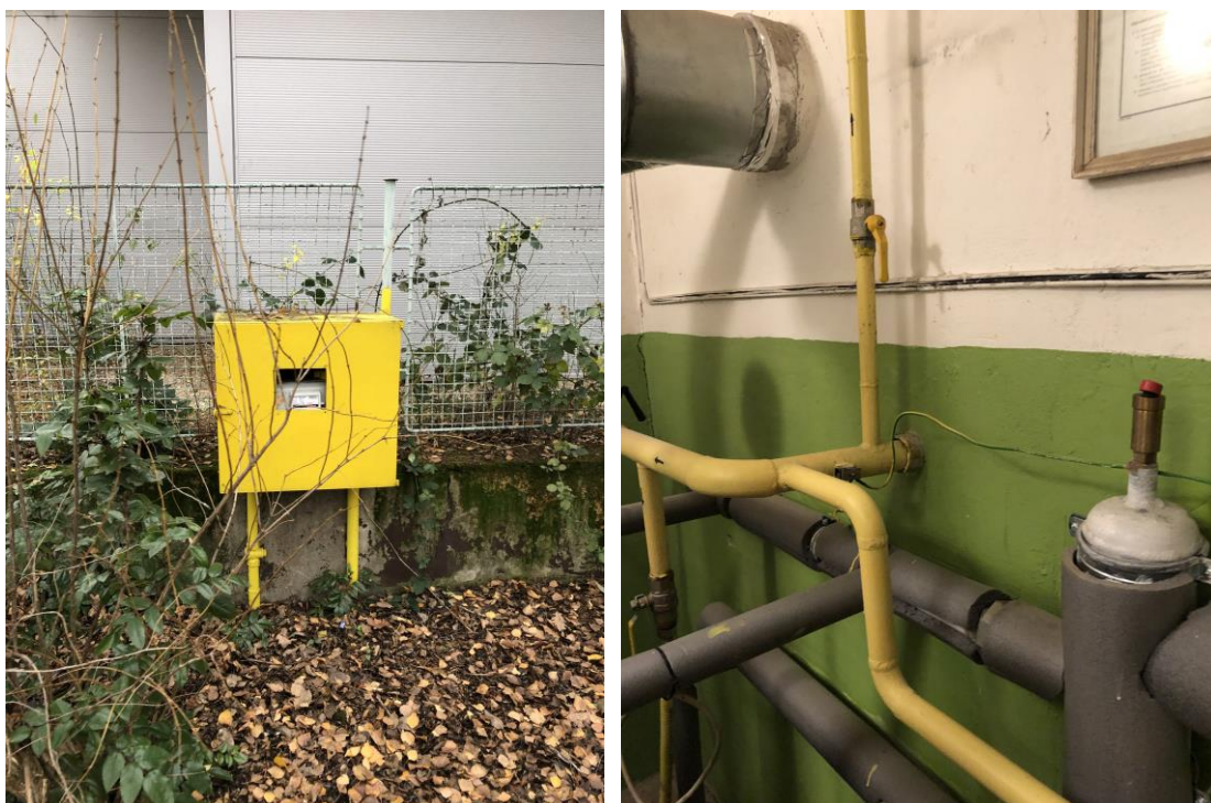
Obr. č.19 – HUP a trasovanie rozvodu plynu
