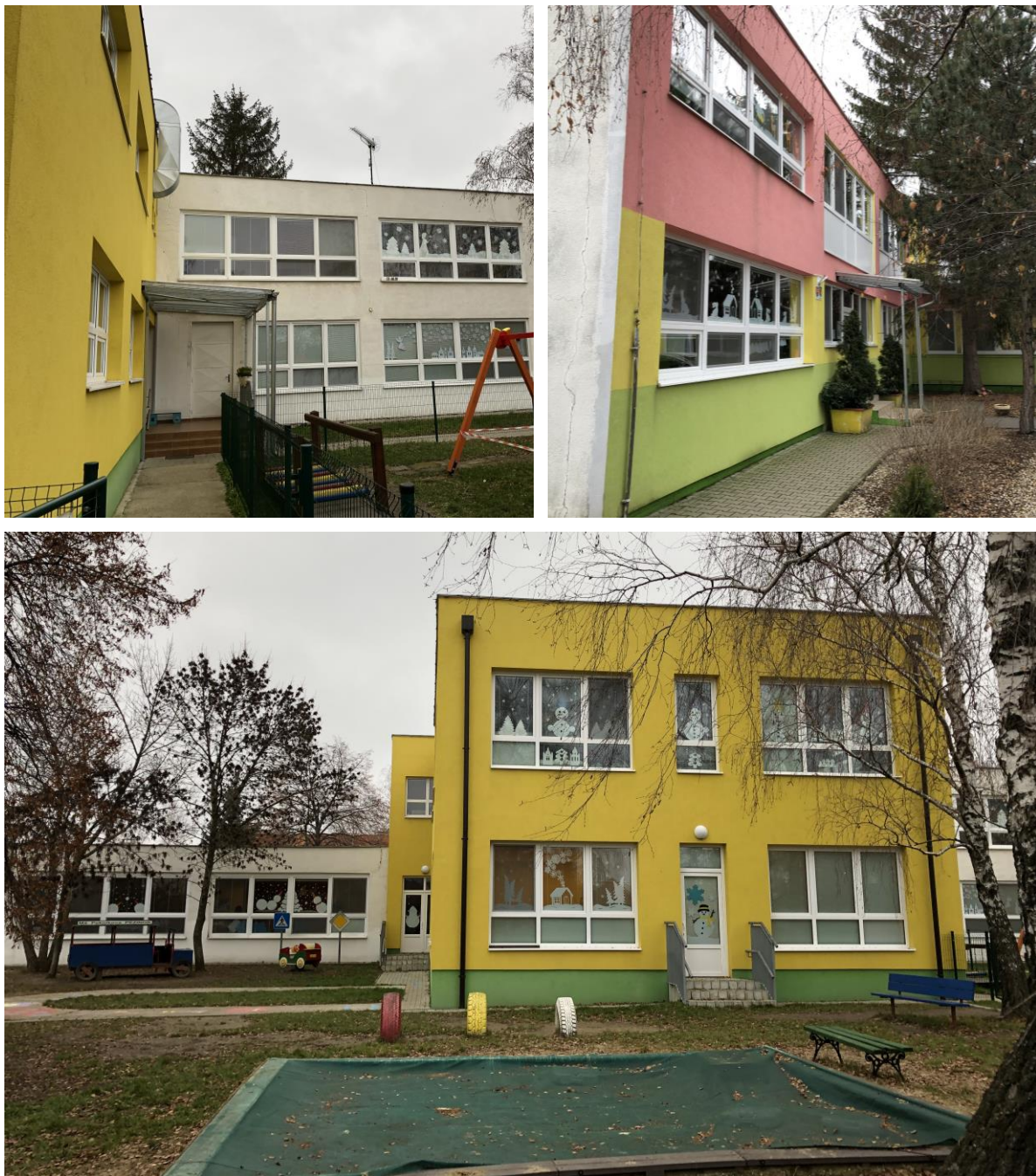
Obr. č. 3 – Pohľady na fasádu objektu
