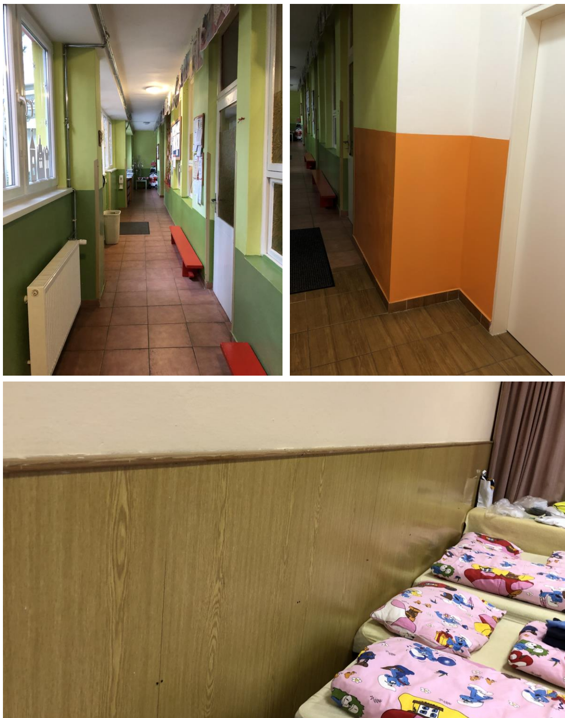
Obr. č. 8 – Úpravy stien interiéru
