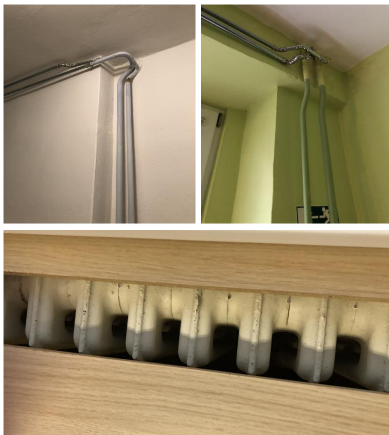
Obr. Č.21 – Pôvodné vykurovacie rozvody a radiátory
