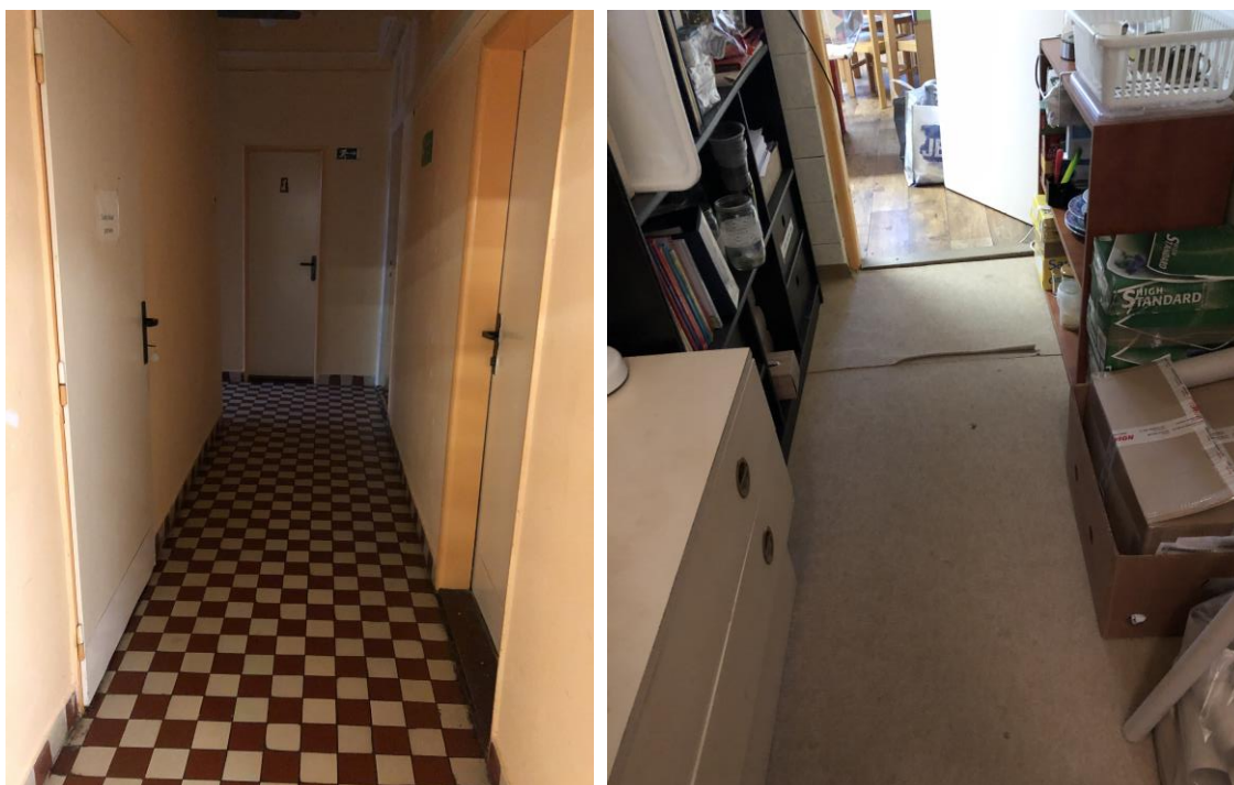
Obr. č. 10 – Pôvodná podlaha na chodbe a sklad
