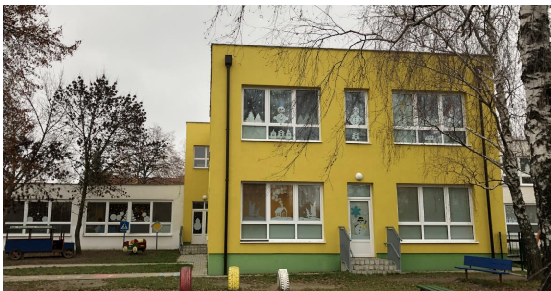
Obr. č. 6 - Vymenené otvorové konštrukcie – plastové okna s izolačným dvojsklom
