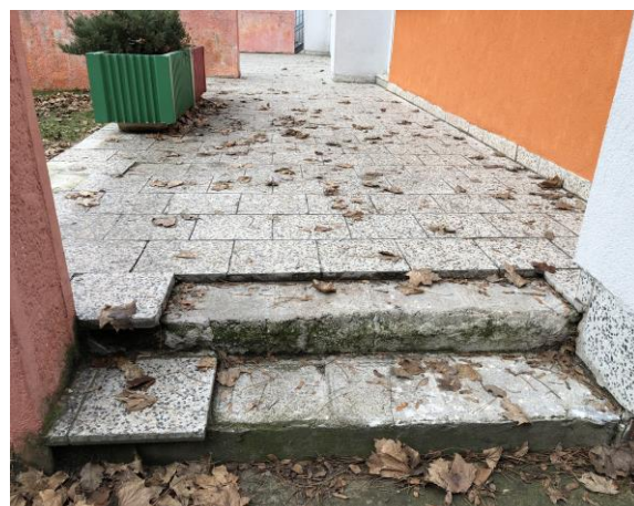
Obr. č.24 – Poškozený exteriérové plochy a terasa
