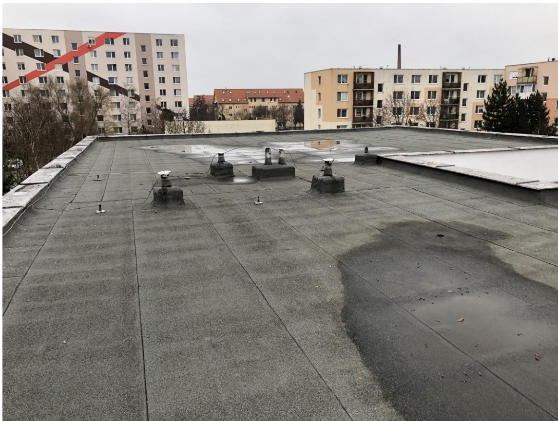
Obr. č. 14 – Plochá strecha objektu
