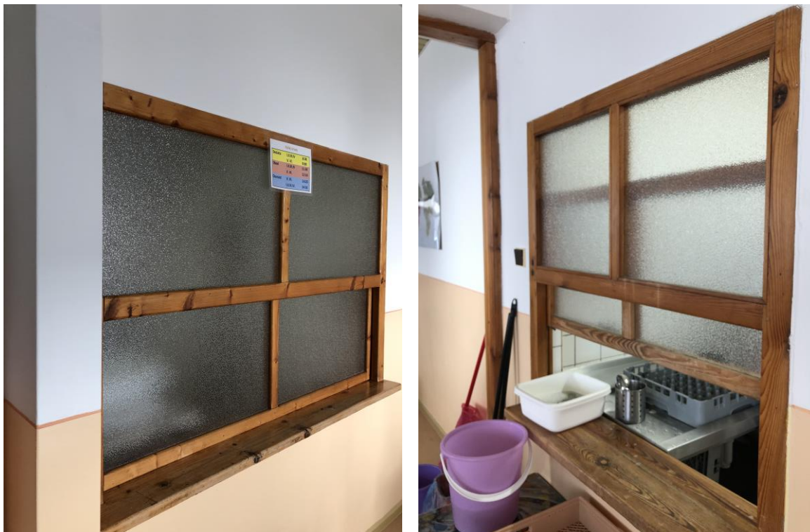
Obr. č. 10 – Vnútorné pôvodné okná
