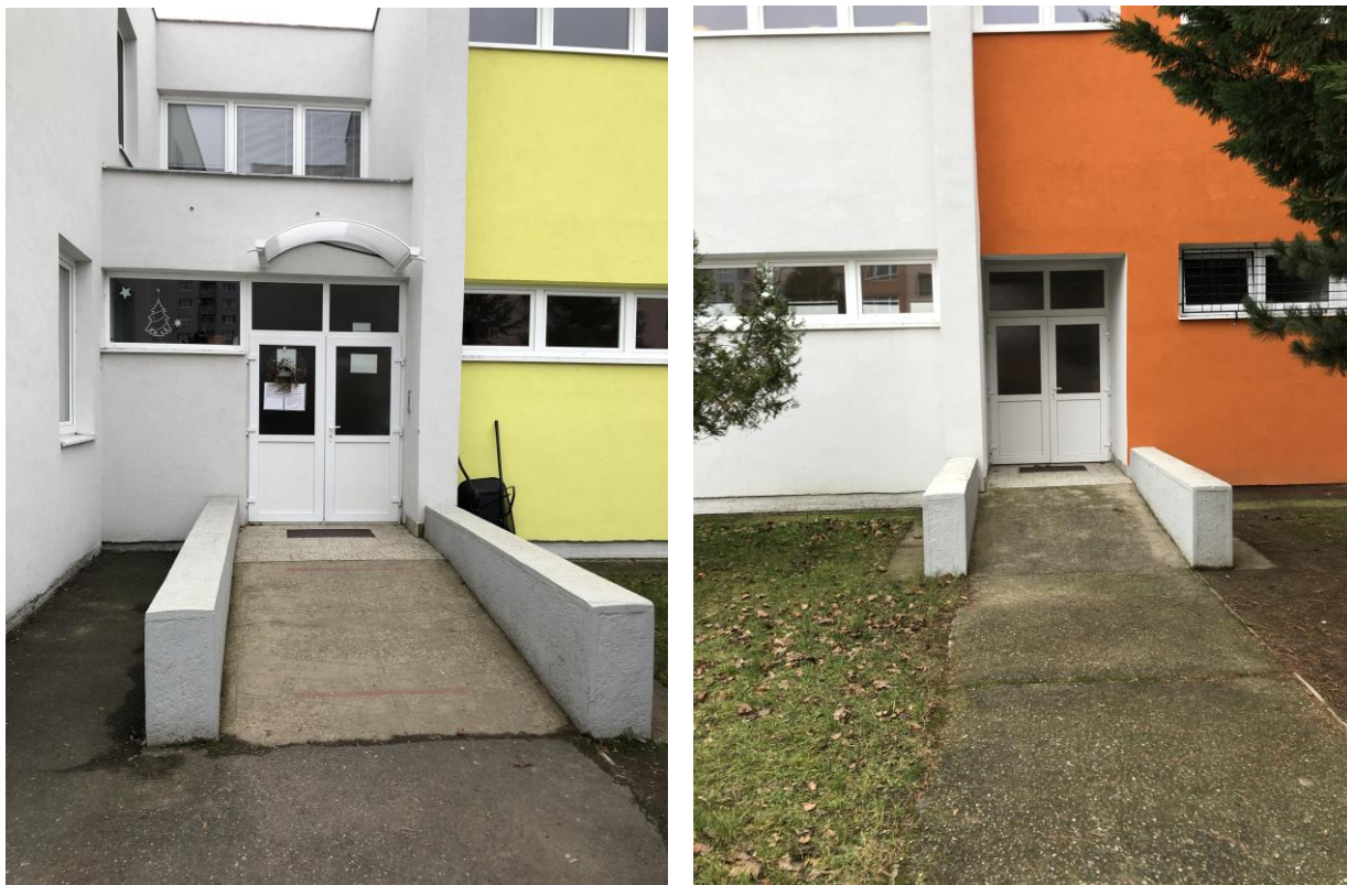
Obr. č. 2 – Bezbariérové vstupy do objektu materskej školy
