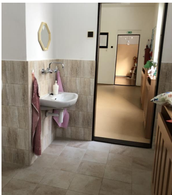
Obr. č. 12 – Úpravy stien interiéru s obkladom
