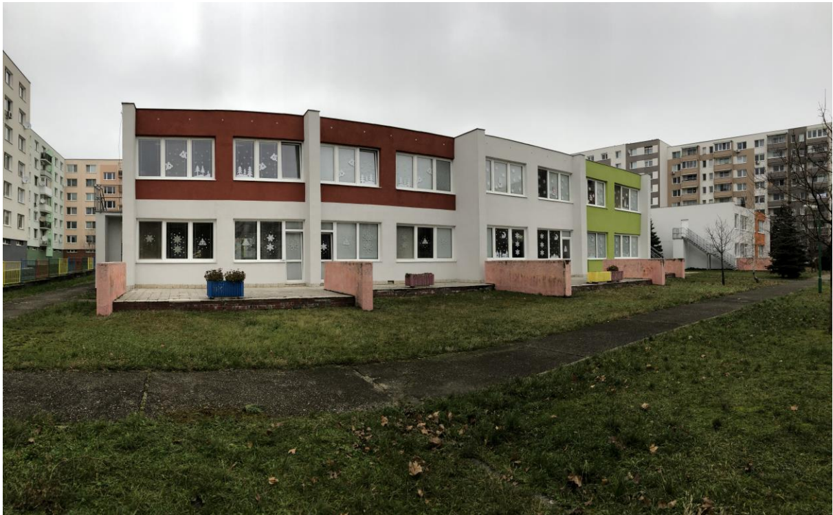
Obr. č. 1 Fotografia priečelia budovy zo dvora
