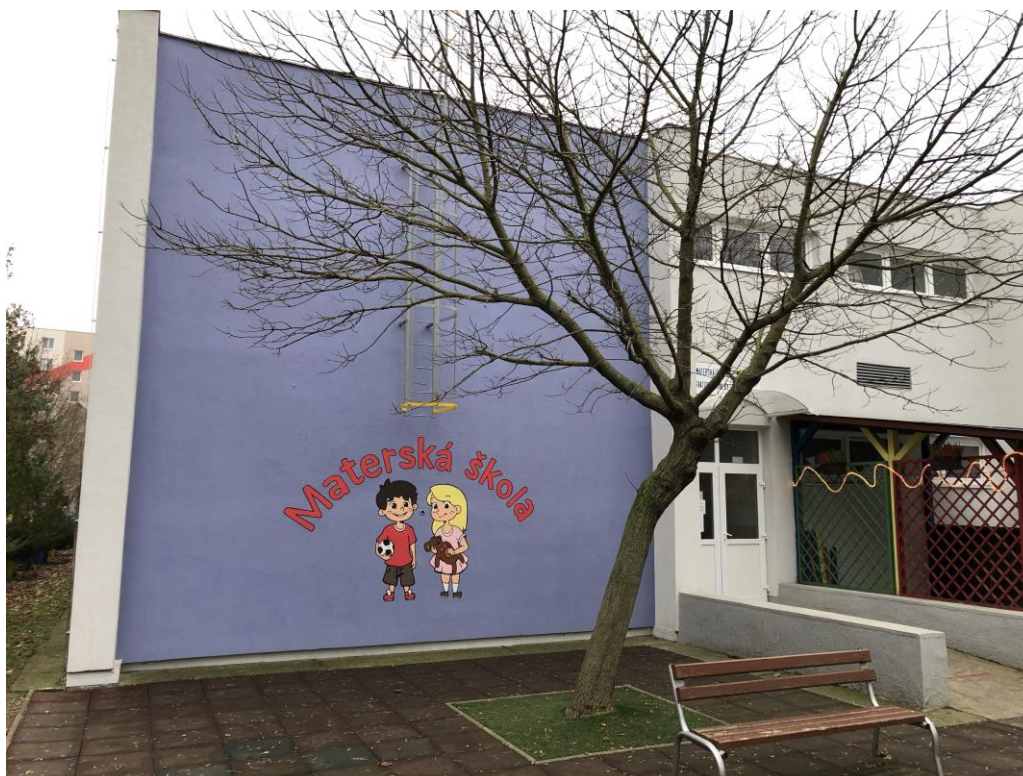
Obr. č. 4 – Pohľad na fasádu objektu – vstup
