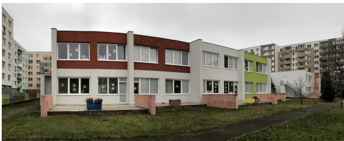
Obr. č. 3 – Pohľady na fasádu objektu - dvor
