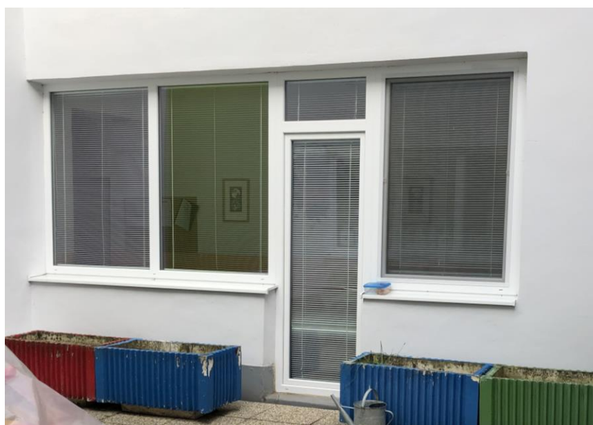
Obr. č. 7 - Vymenené otvorové konštrukcie – plastové okna s izolačným dvojsklom
