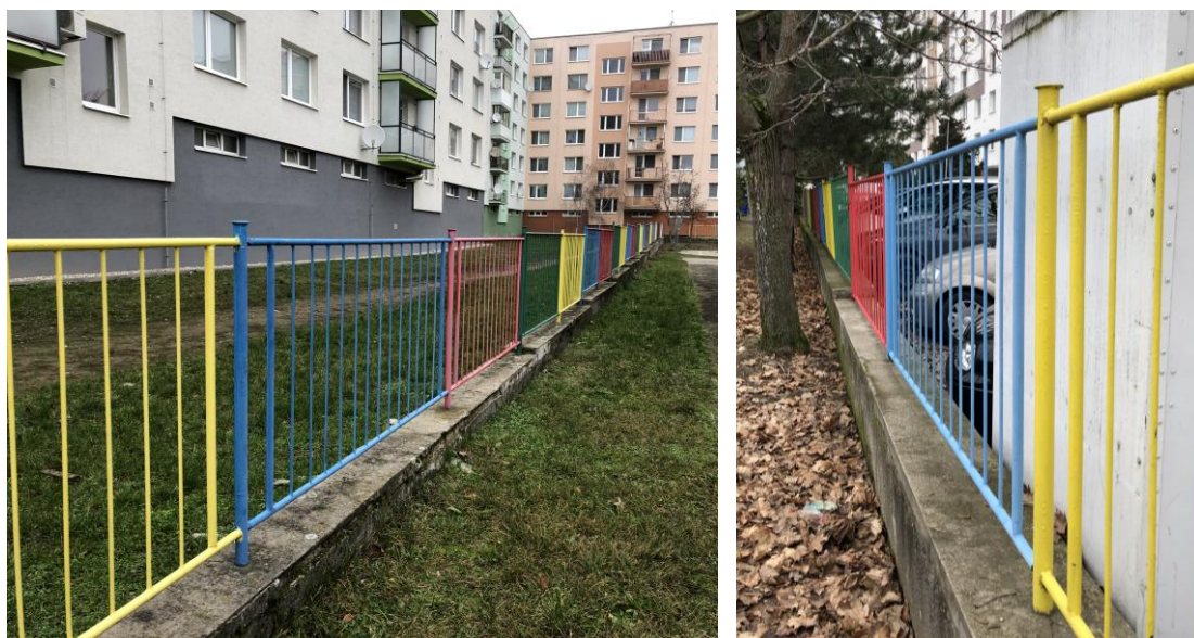
Obr. č.21 – Oplotenie areálu materskej školy
