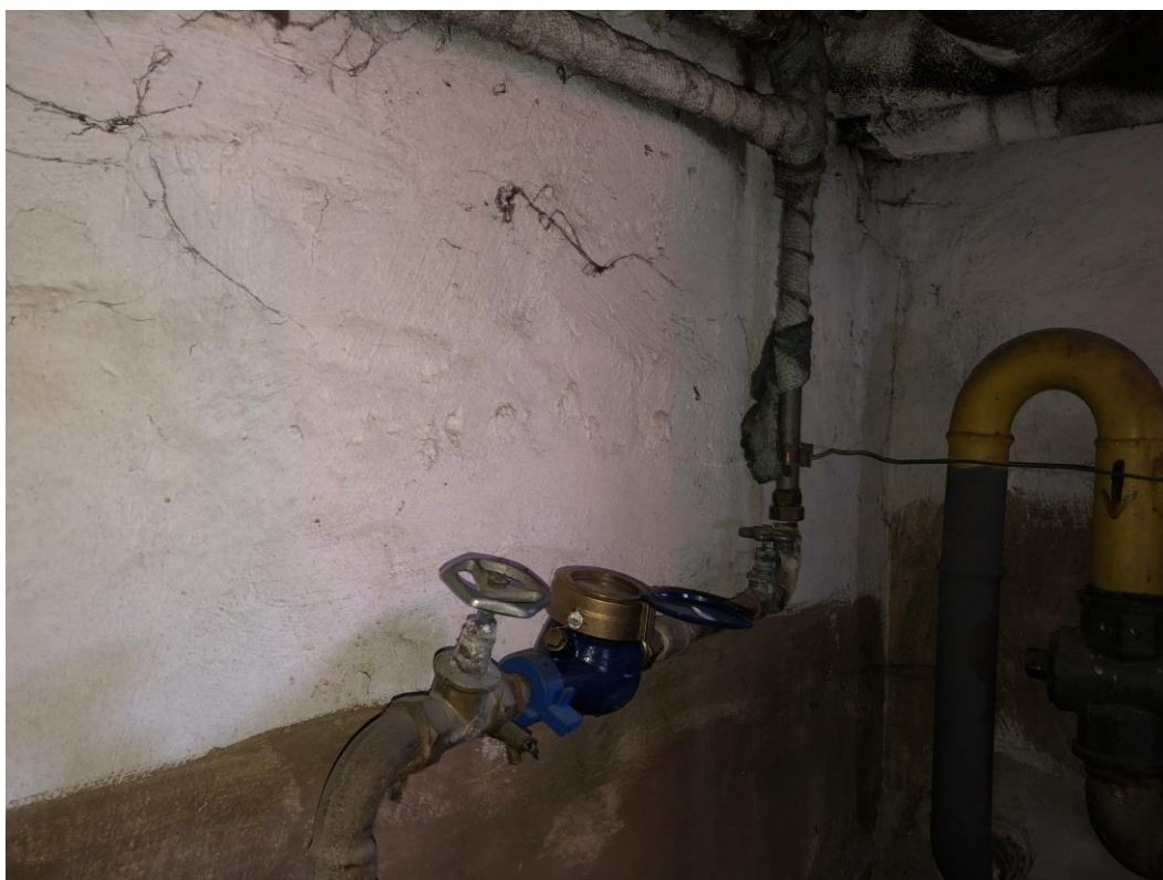
Obr. č.25 – Umiestnenie vodomera v pivničnom priestore
