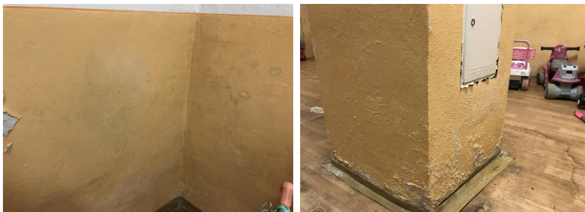
Obr. č. 7 – Zavlhnuté miesta v pivničných priestoroch .
