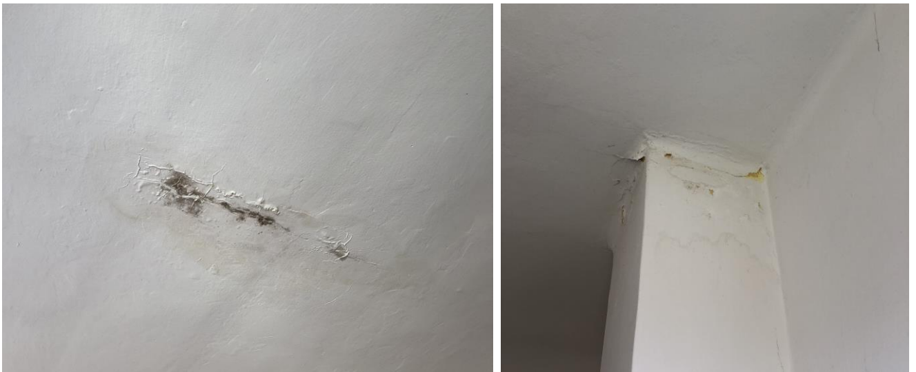
Obr. č. 17 – Zvlhnuté a poškozené stropy
