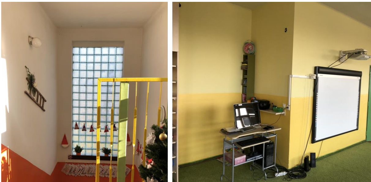
Obr. č. 12 – Úpravy stien interiéru
