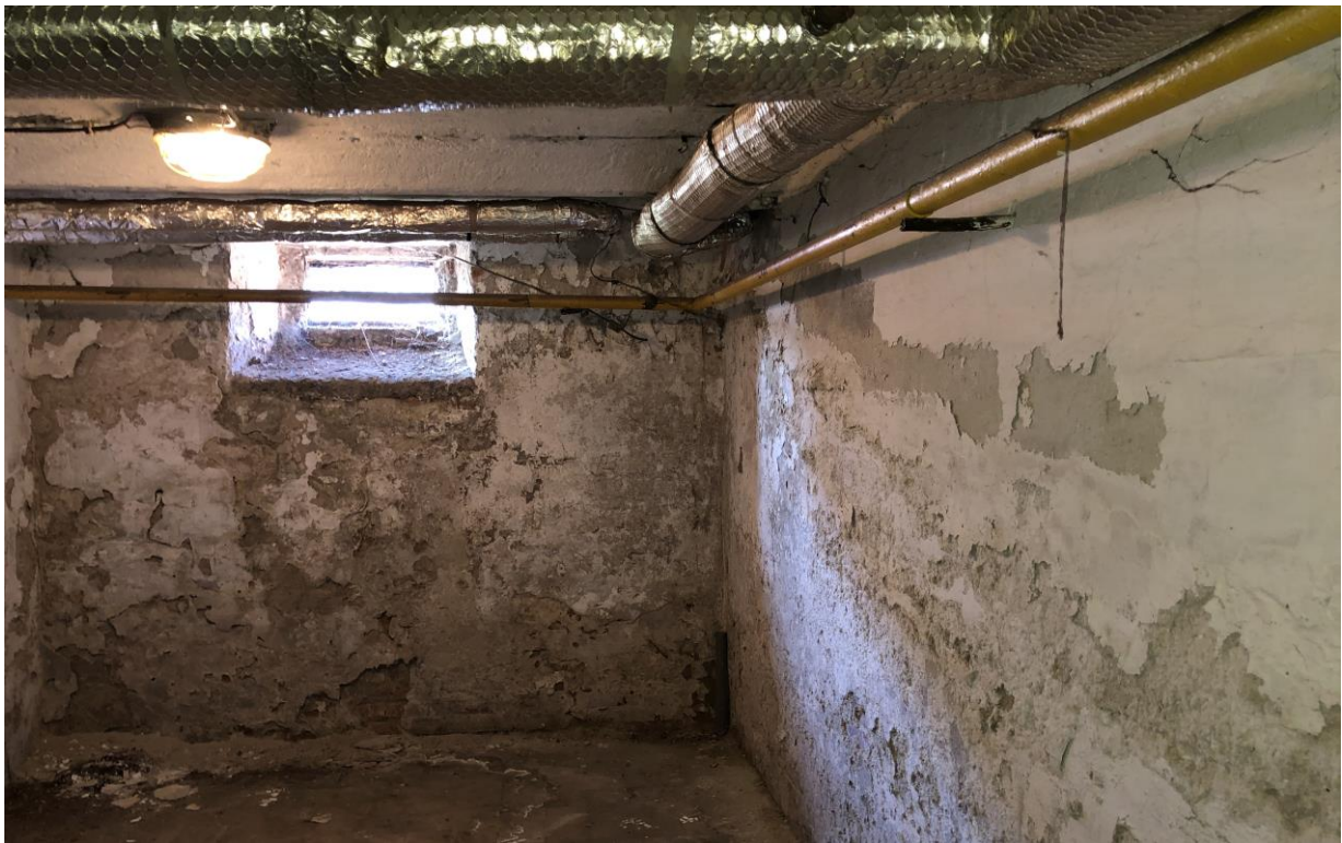
Obr. č. 16 – Poškozené a zvlhnuté steny
