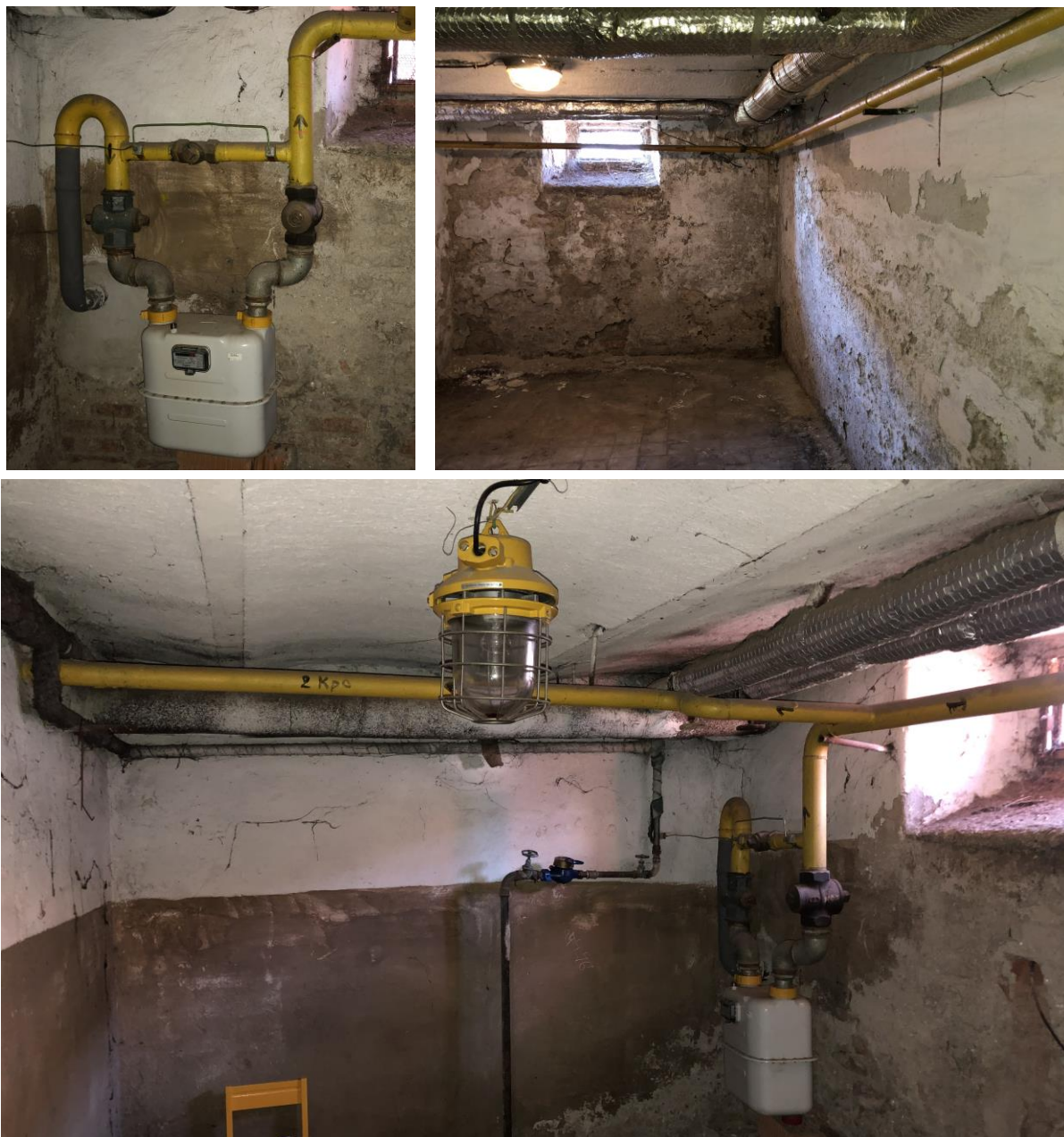
Obr. č. 27 – HUP a trasovanie rozvodu plynu
