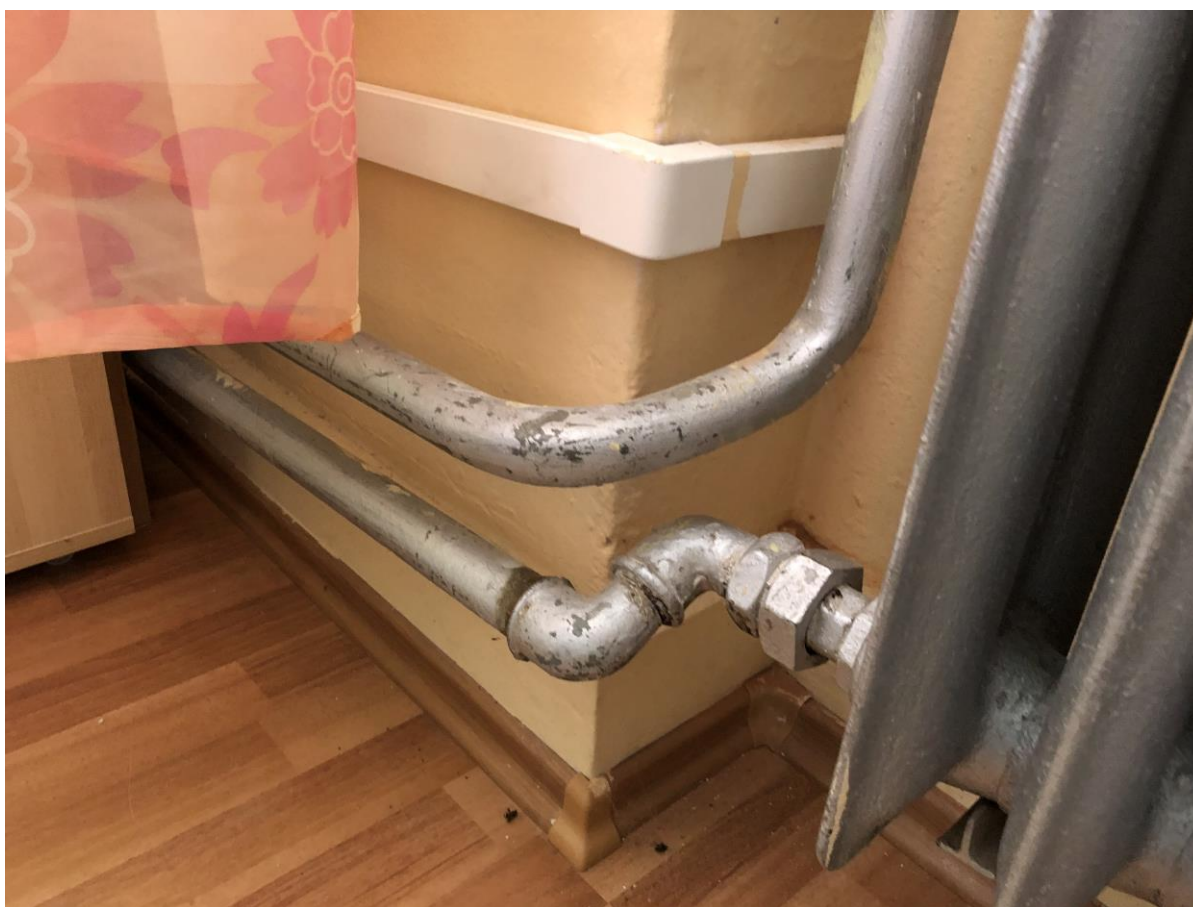
Obr. č.30 – Pôvodné vykurovacie rozvody a radiátory
