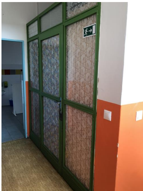
Obr. č. 9 - Vnútorne pôvodné presklenné drevené steny
