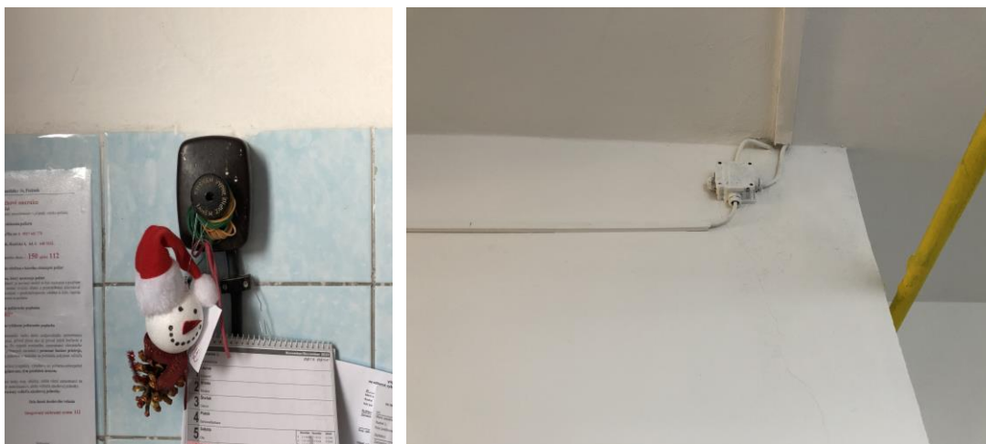
Obr. č.32 – Elektroinštalácia a vypínače
