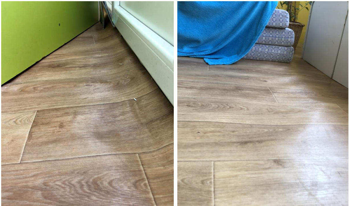
Obr. č. 5 – Nerovné a prepadnuté miesta na podlahe v hracích miestnostiach
