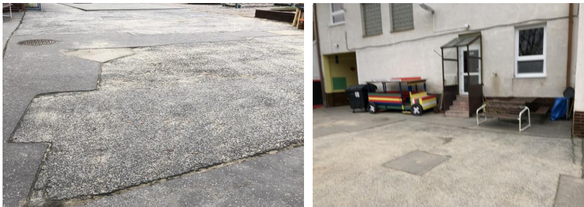
Obr. č. 22 – Poškodené spevnené plochy
