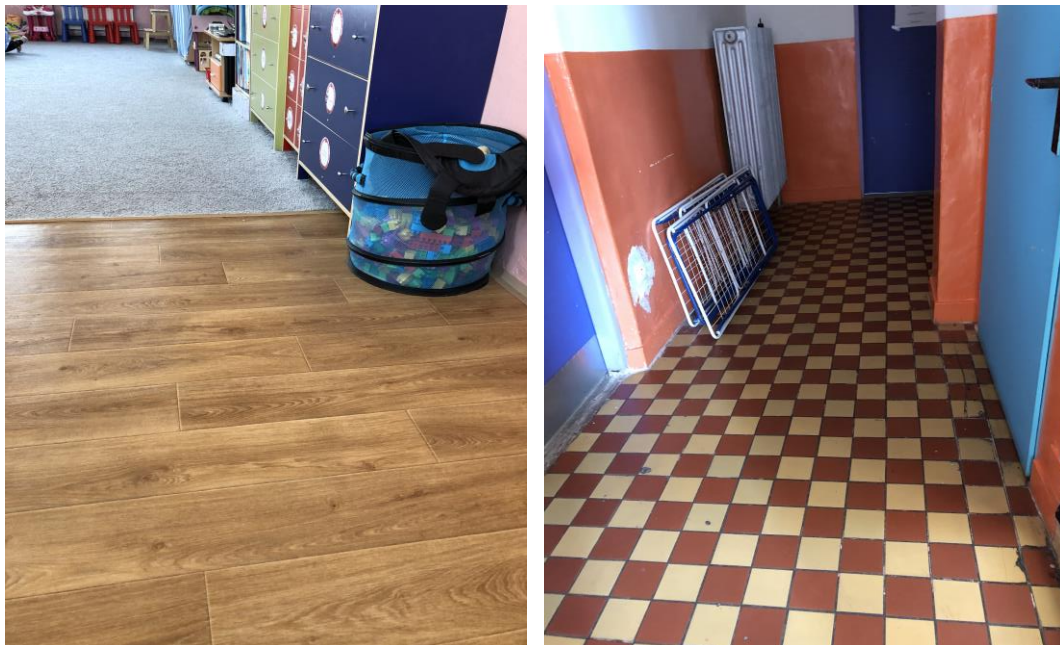
Obr. č. 14 – Podlahy v triedach a na chodbách
