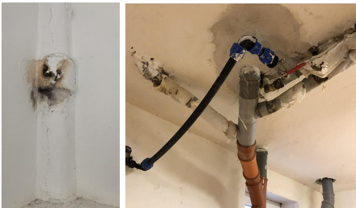
Obr. č. 26 – Vnútorne rozvody splaškovej kanalizácie
