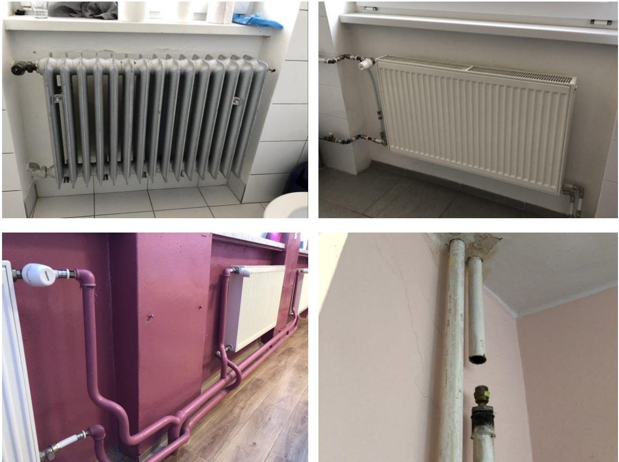
Obr. č.29 – Vykurovacie telesá, rozvod vykurovania.
