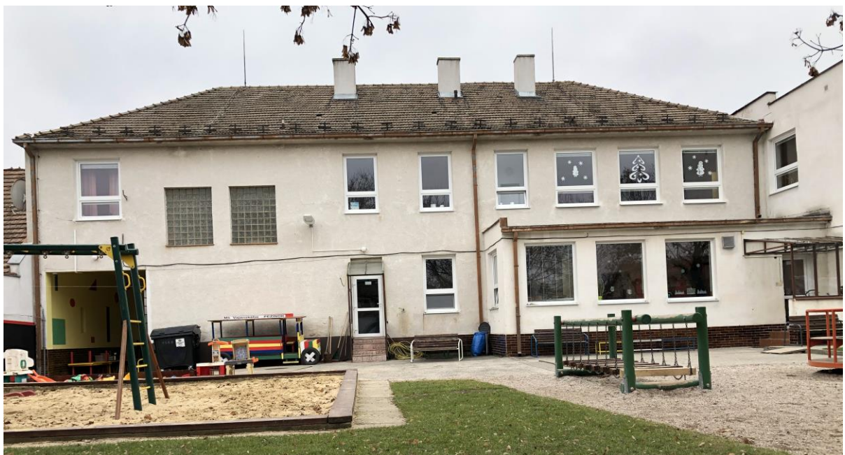
Obr. č. 4 – Pohľady na fasádu objektu zo dvora materskej školy
