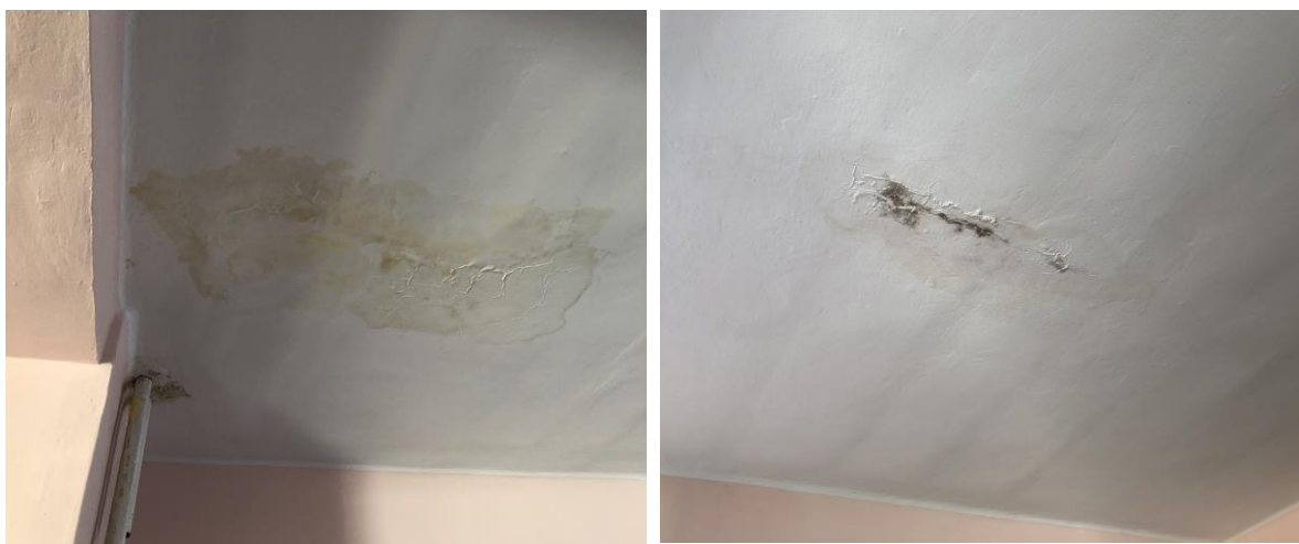
Obr. č. 6 – Zatekanie stropu na druhom nadzemnom podlaží.
