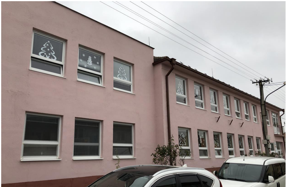
Obr. č. 8 - Vymenené otvorové konštrukcie – plastové okna s izolačným dvojsklom
