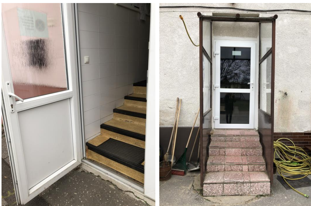
Obr. č. 2 – Vstup do objektu školy
