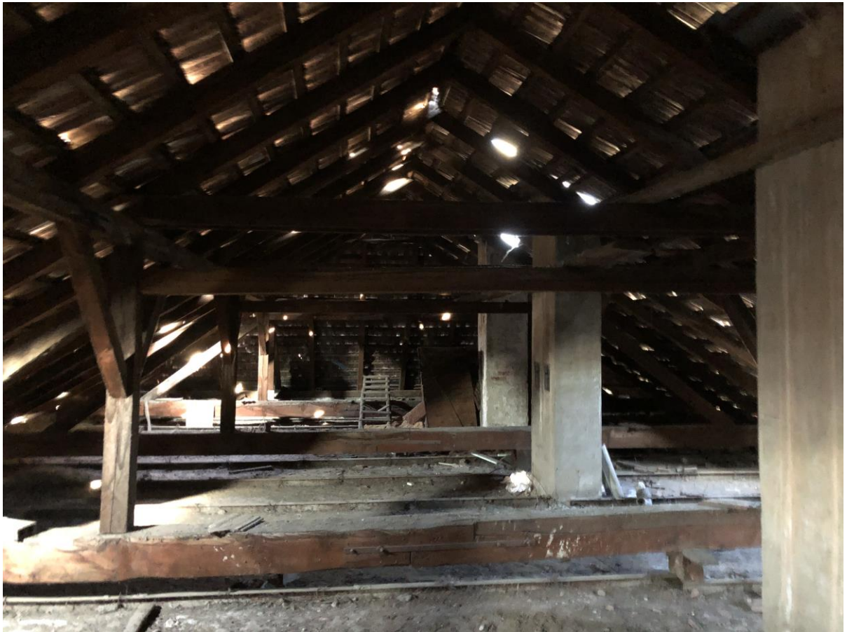
Obr. č. 18 – Strešná krytina bez záklopu a fólie – priestor povaly
