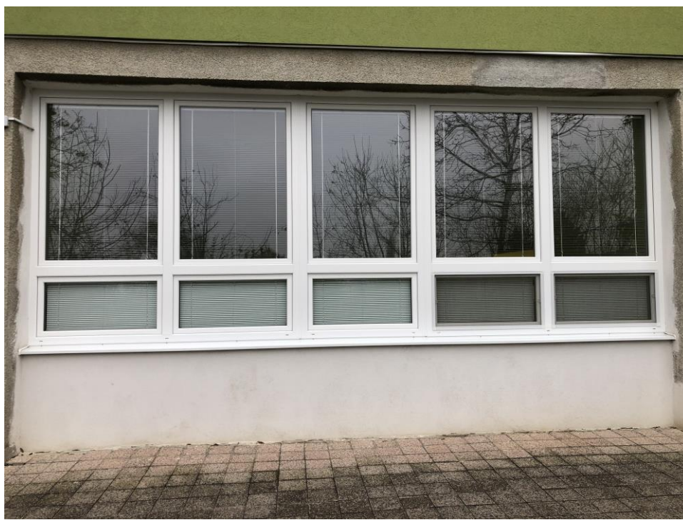
Obr. č. 5 - Vymenené otvorové konštrukcie – plastové okna s izolačným dvojsklom
