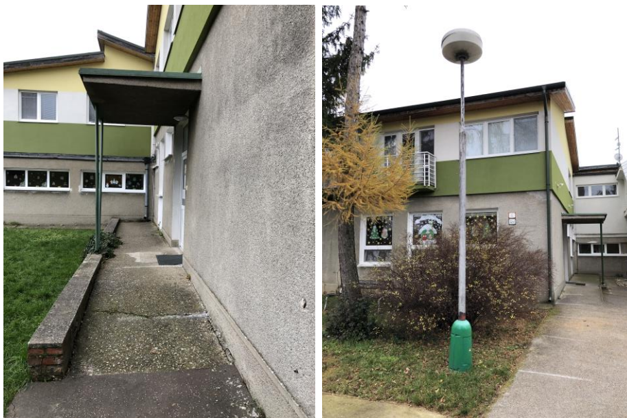
Obr. č. 2 – Bezbariérový vstup do objektu školy
