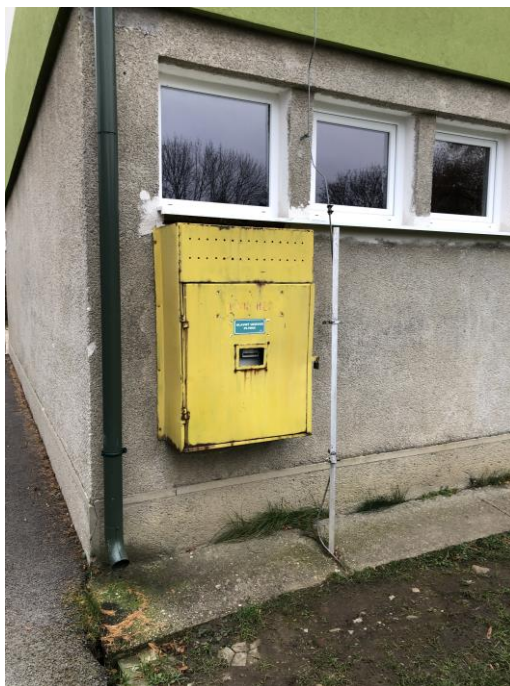
Obr. č. 14 – HUP a trasovanie rozvodu plynu
