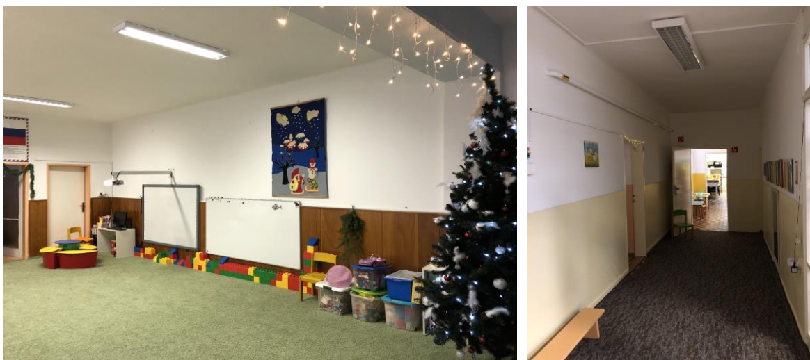
Obr. č. 12 – Úpravy stien interiéru
