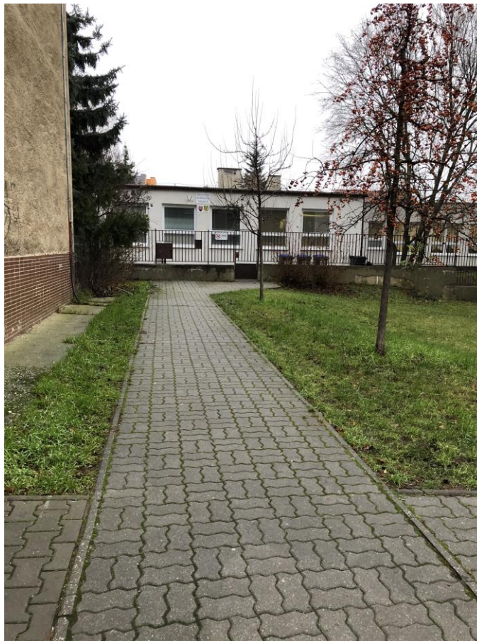
Obr. č.22 – Uličný verejný priestor pre objektom materskej školy
