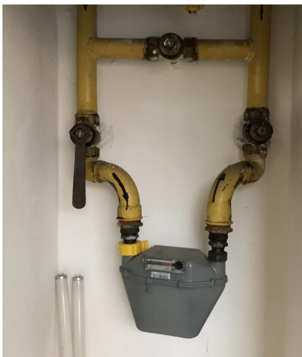
Obr. č.26 – HUP a meranie plynu
