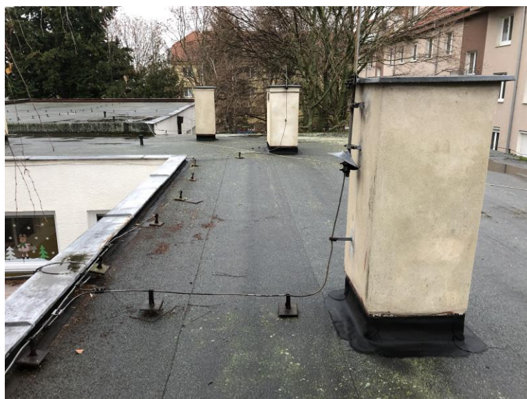
Obr. č. 15 – Plochá strecha objektu
