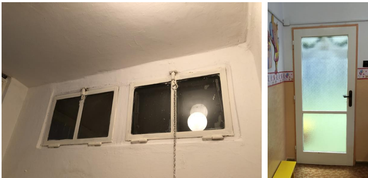
Obr. č. 11 – Vnútorné pôvodné okná a dvere
