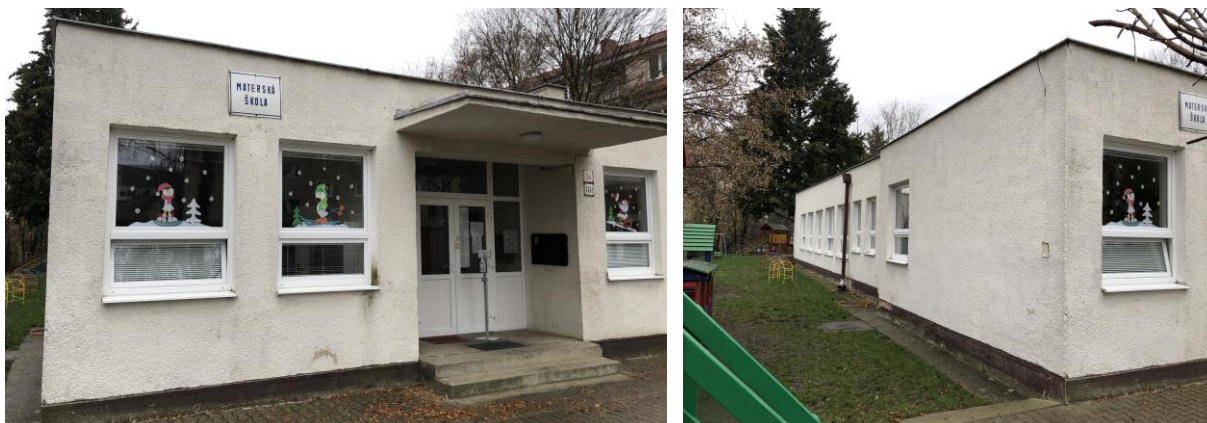
Obr. č. 3 – Pohľady na fasádu objektu
