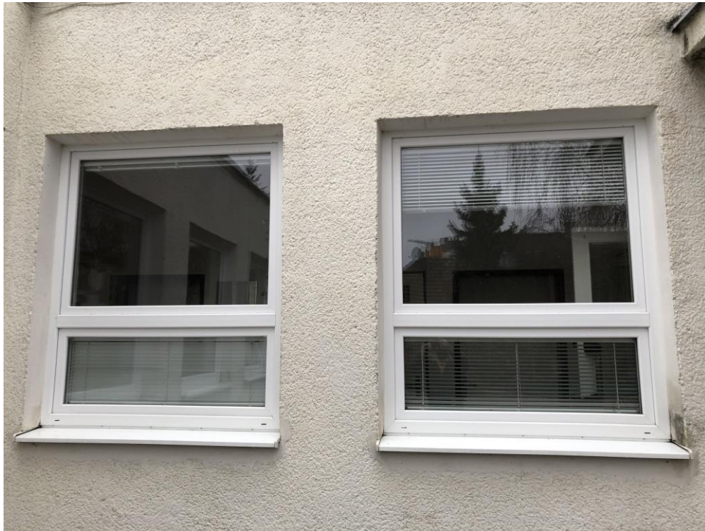
Obr. č. 7 - Vymenené otvorové konštrukcie – plastové okna s izolačným dvojsklom
