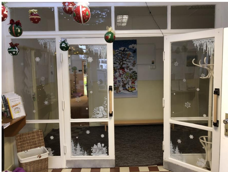
Obr. č. 8 - Vnútorne pôvodné presklenné drevené steny
