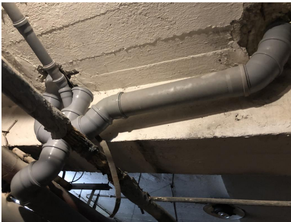
Obr. č. 30 - Nové kanalizačné potrubie v I. PP pod priestormi kuchyne
