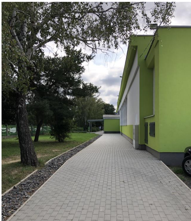
Obr. č. 19 - Zrekonštruované spevnené plochy pred objektom školy
