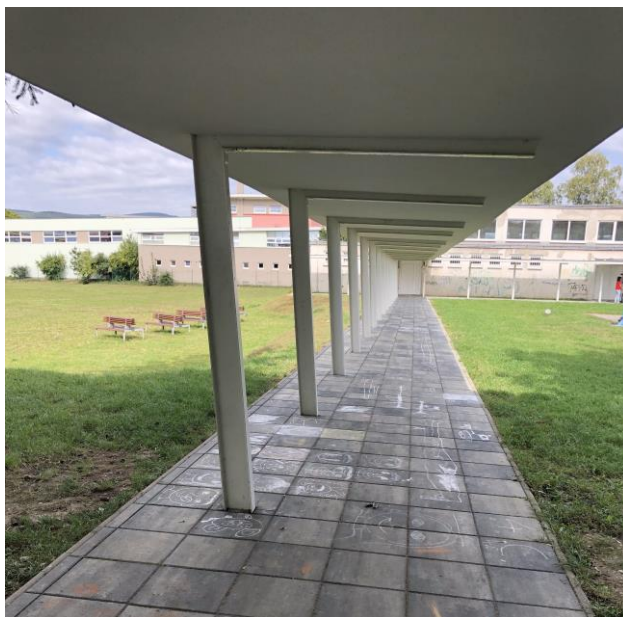
Obr. č. 18 - Prestrešený chodník z objektu školy do telocvične
