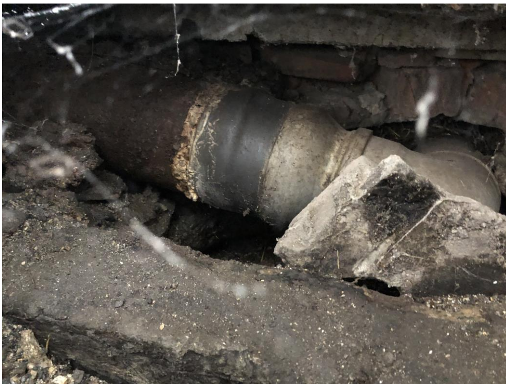
Obr. č. 35 - Čiastočné opravy ležatých rozvodov kanalizačného potrubia.
