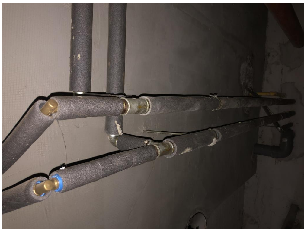
Obr. č. 21 Prepojenie pôvodného oceového rozvodu vody s novým PP rozvodom
