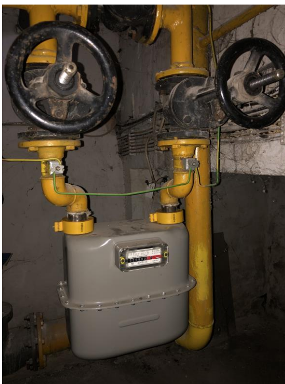
Obr. č. 37 - Plynomer umiestnený v I. PP
