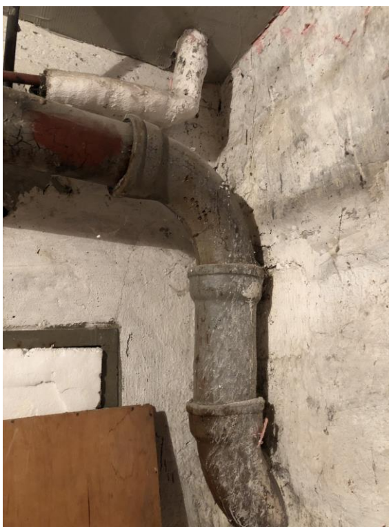
Obr. č. 29 - Prepojenie pôvodného liatinového kanalizačného potrubia s novým PVC potrubím v suteréne objektu
