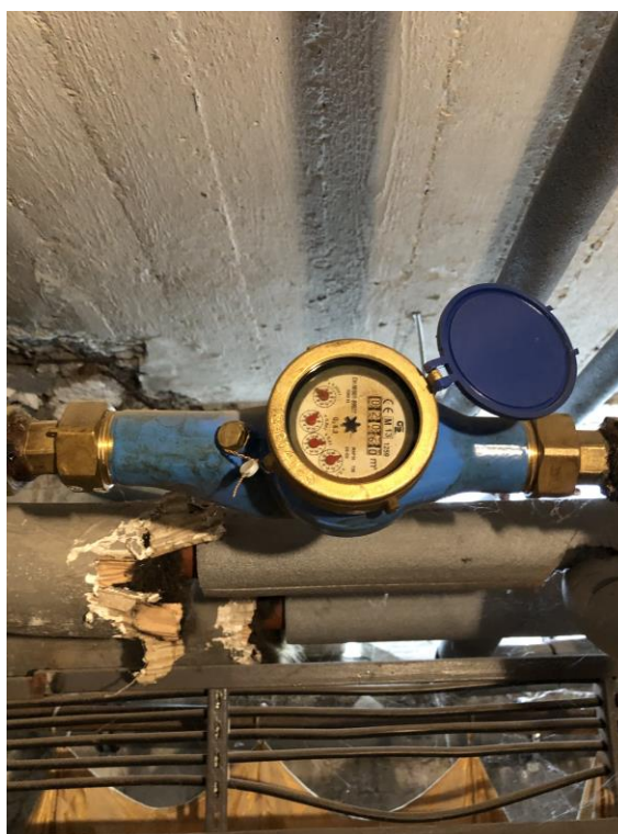
Obr. č. 22 - podružný vodoměr
