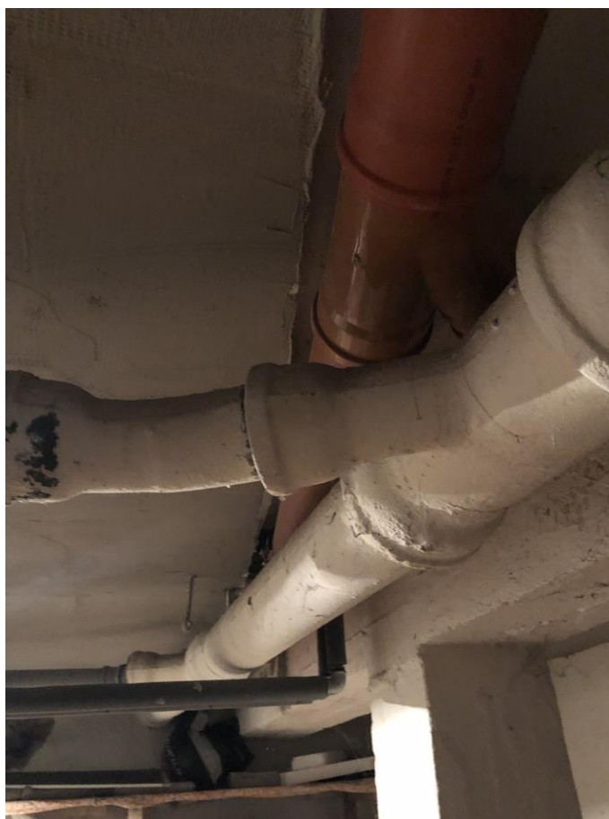
Obr. č. 31 - Križovanie pôvodného liatinového a nového PVC kanalizačného potrubia
