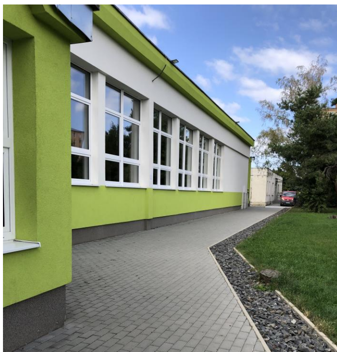
Obr. č. 15 - Vymenené otvorové konštrukcie – plastové okna s izolačným dvojsklom
