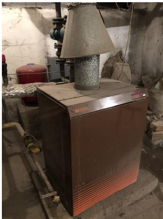
Obr. č. 38 - Plynový kotol DESTILA DPL 45
