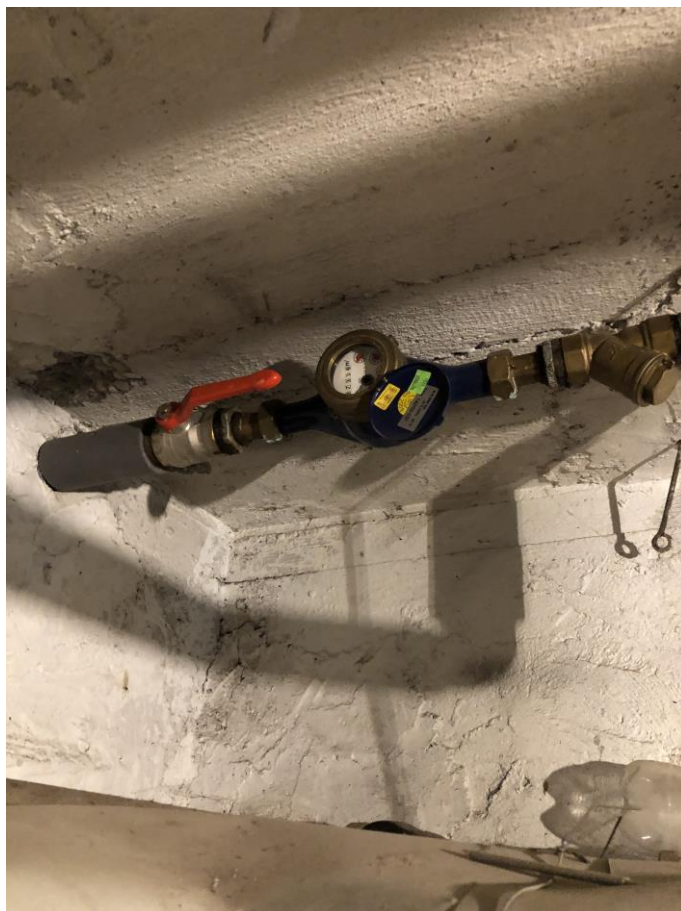
Obr. č. 23 - podružný vodoměr
