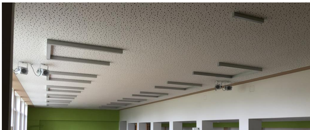
Obr. č. 16 - Akustický strop v jedálni
