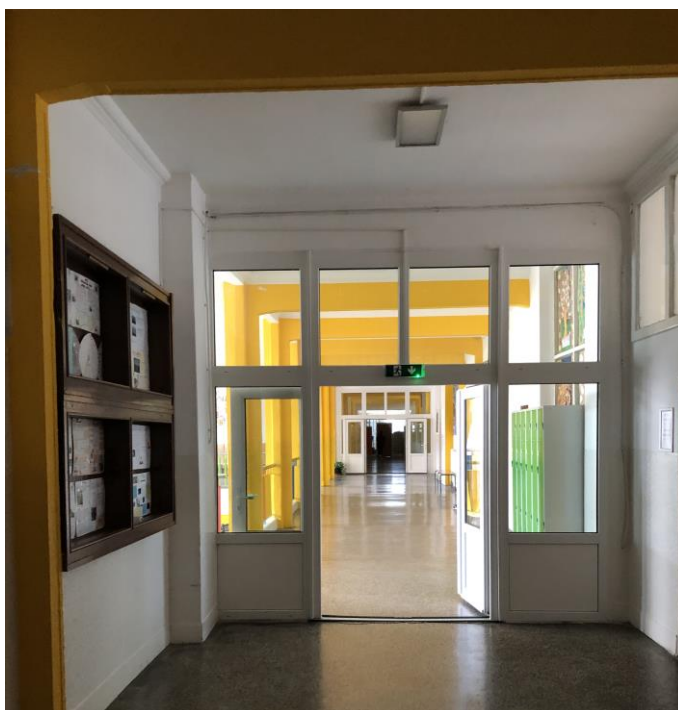
Obr. č. 16 - Vnútorne presklenné steny plastové s izolačným dvojsklom
