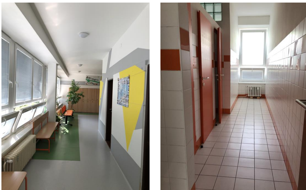
Obr. č. 9 – Obklady z LDT dosky na chodbe a keramický obklad na sociálnom zariadení
