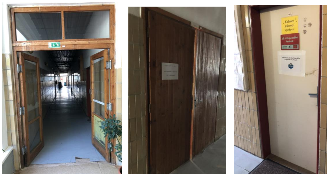
Obr. č. 8 – Pôvodné vnútorné dvere v telocvičňovom trakte
