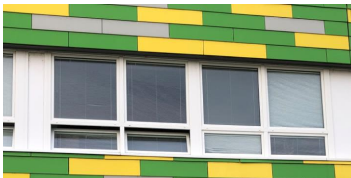
Obr. č. 5 - Vymenené otvorové konštrukcie – plastové okna s izolačným dvojsklom
