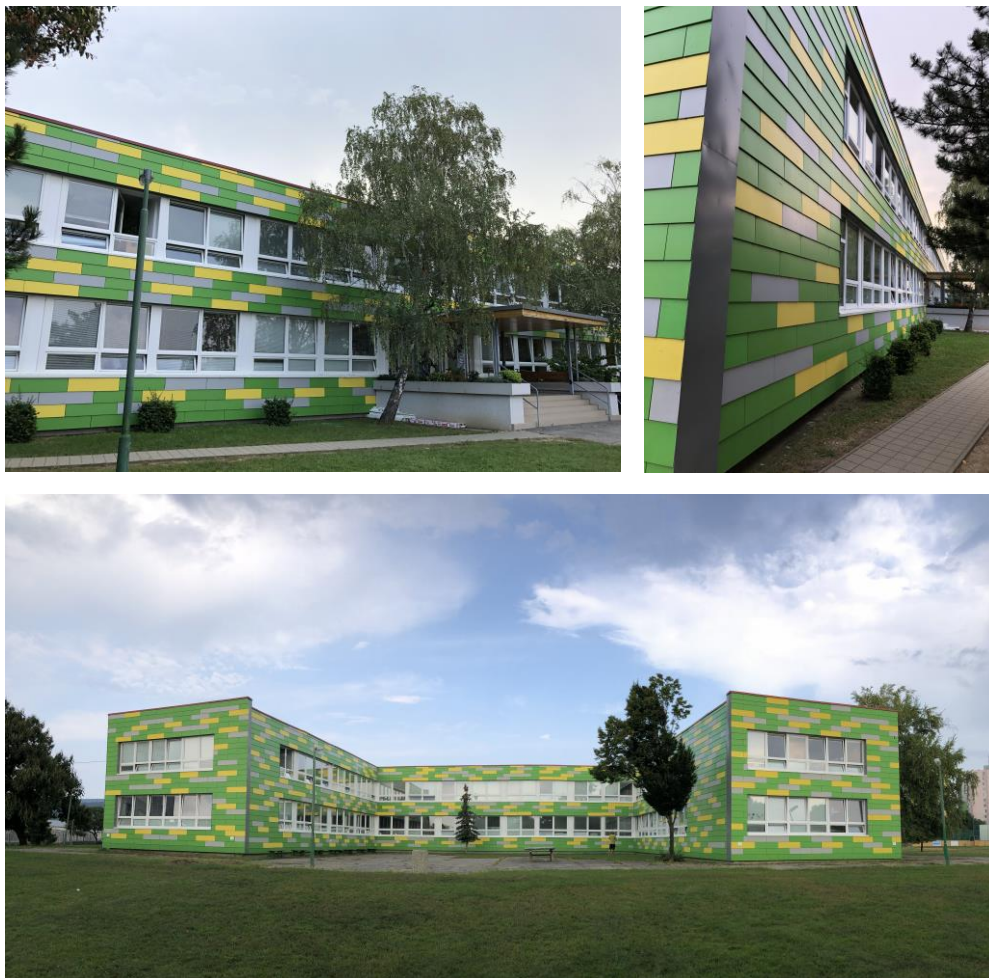
Obr. č. 3 – Pohľady na fasádu objektu
