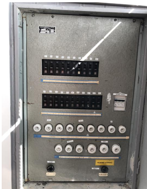
Obr. č.23 – Rozvádzač na prízemí a osvetlenie v triedach na chodbe pri telocvični
