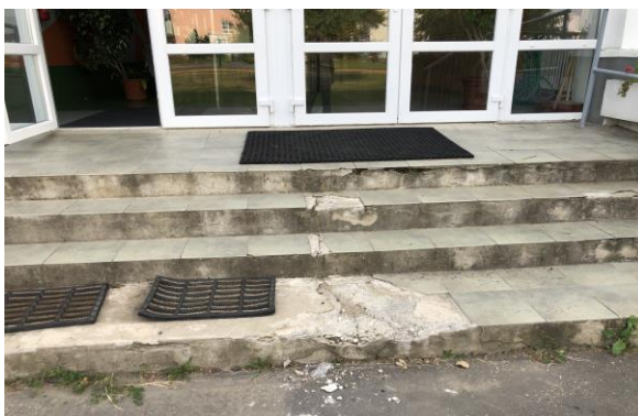
Obr. č.14 – Poškodené spevnené plochy v areáli školy
