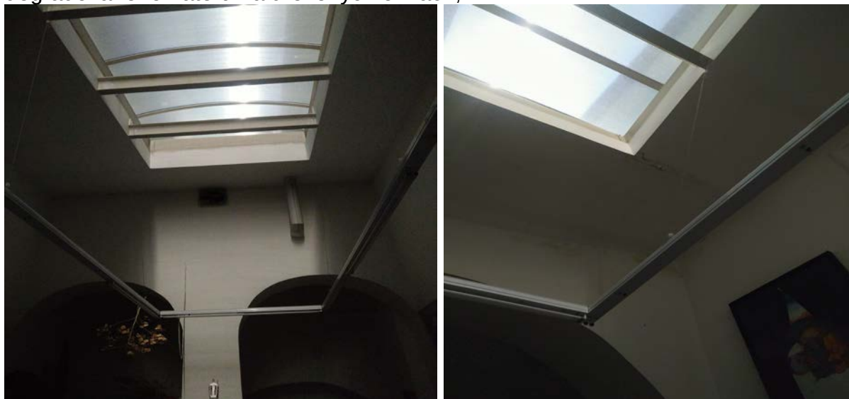
Estetické vady povrchu omietok a zatekanie cez svetlík
