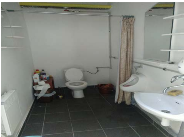
Estetické vady povrchu omietok a lepené spoje PVC kanalizácie
