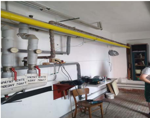
Estetické vady povrchu omietok a potrubí
