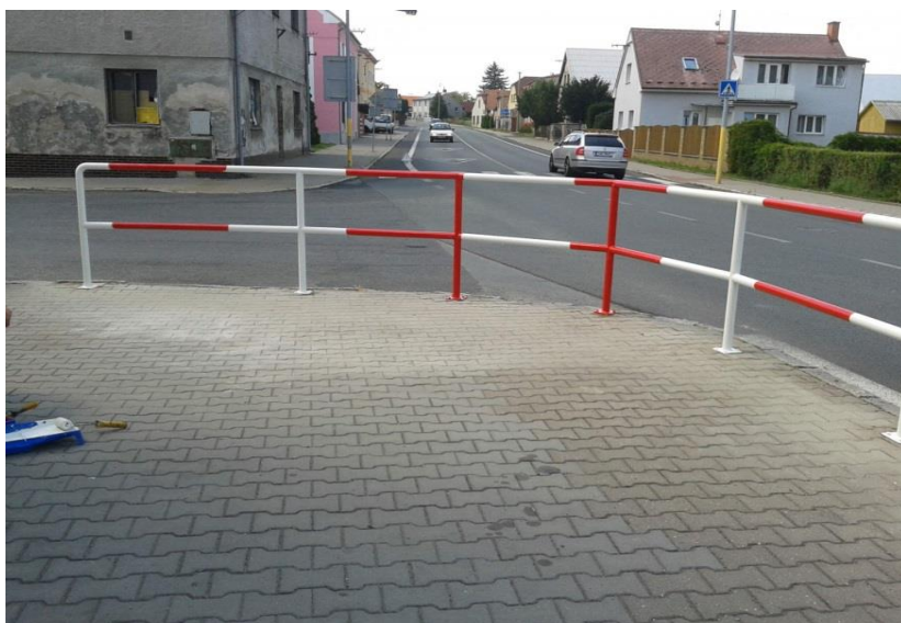
Obr. č. 1 - vzor typizovaného zábradlia
